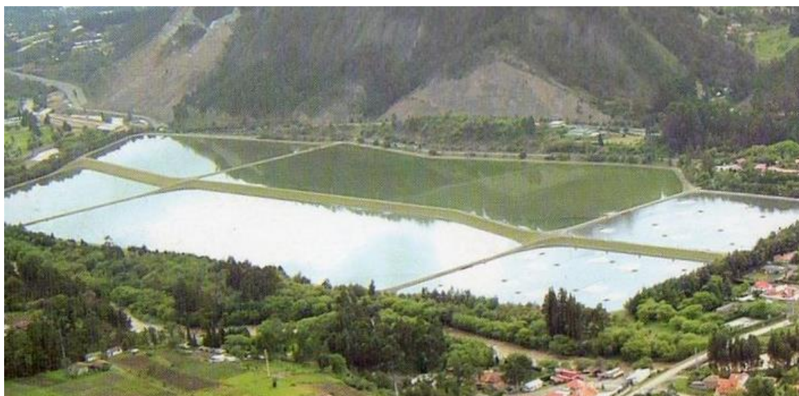
Figura 3.2 ETE Ucubamba, Cuenca, Equador. Fonte: ETAPA EP (2015)
