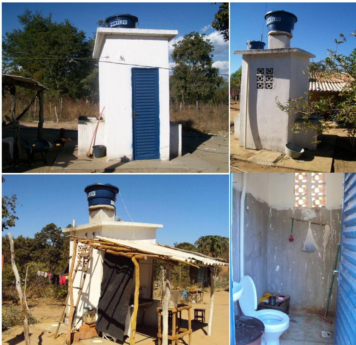
Figura 27 – Banheiros construídos em Lagedo com recursos da Funasa. Em baixo a esquerda uma coberta adaptada ao banheiro feita por um morador.
