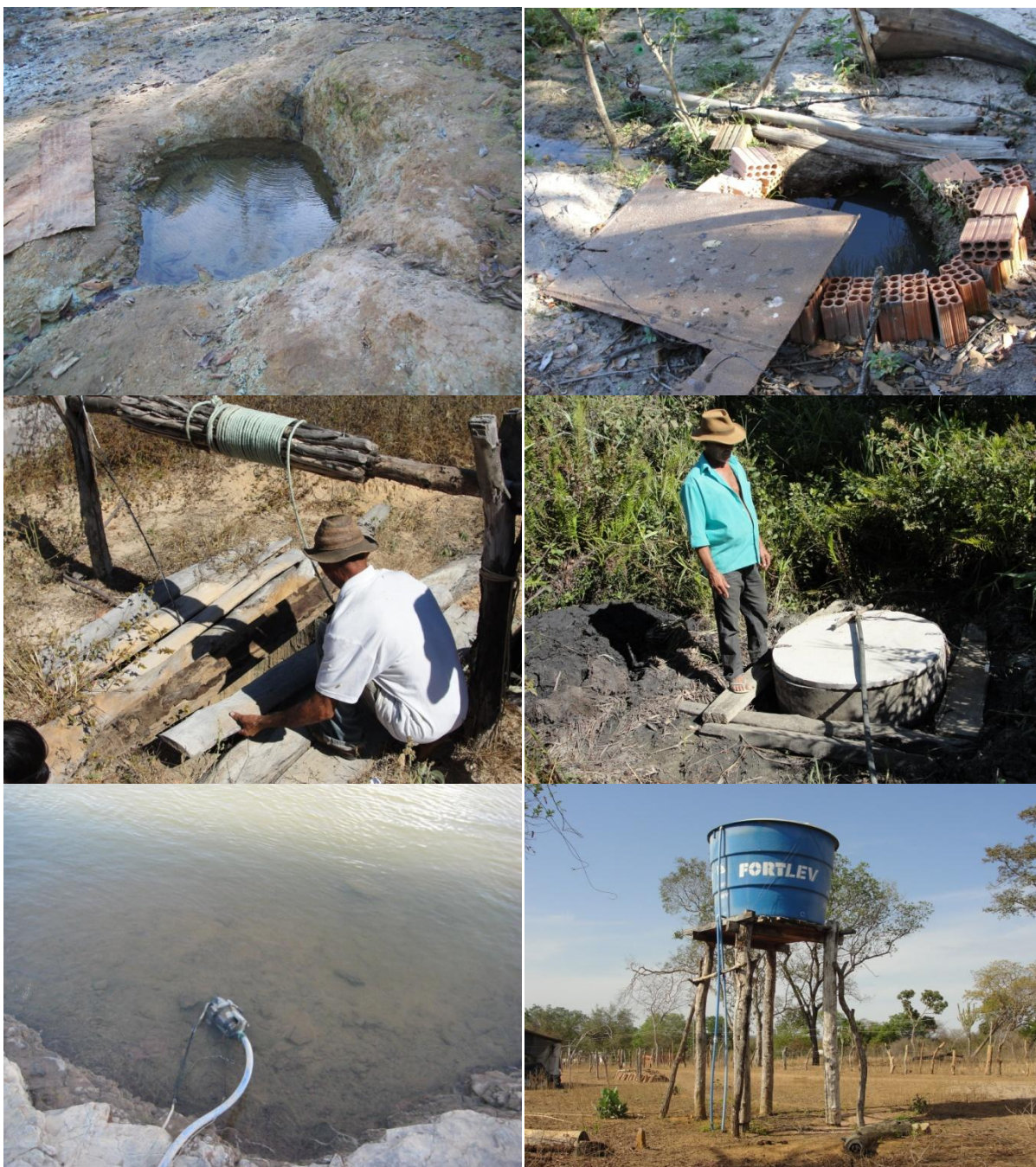
Figura 24 – Fontes de captação de água em Lagedo. Duas primeiras, cacimbas cavadas na beira do rio São Francisco e em vereda; No meio, poços cavados e mantidos por moradores; duas últimas, bomba individual utilizada para captação no Rio São Francisco e Caixa d'água de 10.000 litros que armazena água do mesmo rio distribuída para cerca de 20 casas sem tratamento.
