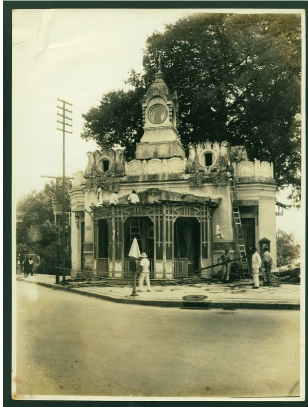
Figura 12 - Demolição da Agência de Bondes situada na Rua da Bahia (1945).
