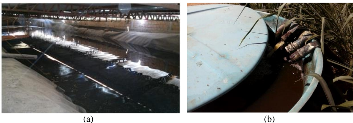
Figura 4.1 - (a) Lagoa de estabilização localizada no aterro sanitário de Sabará-MG (CTR Macaúbas); (b) tanque de equalização localizado no aterro sanitário de Belo Horizonte-MG (BR-040)
