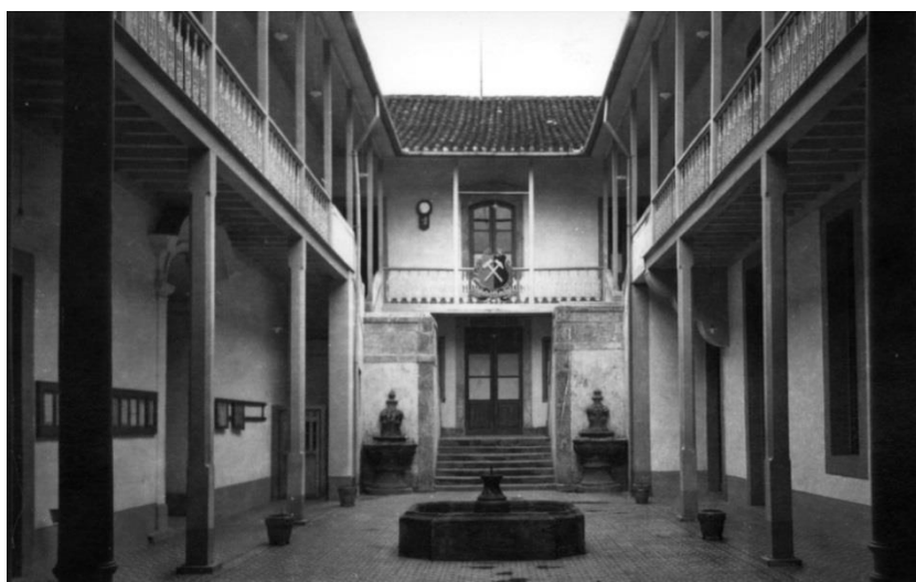
FIGURA 9 - Vista do pátio interno do Palácio dos Governadores, década de 1940.
