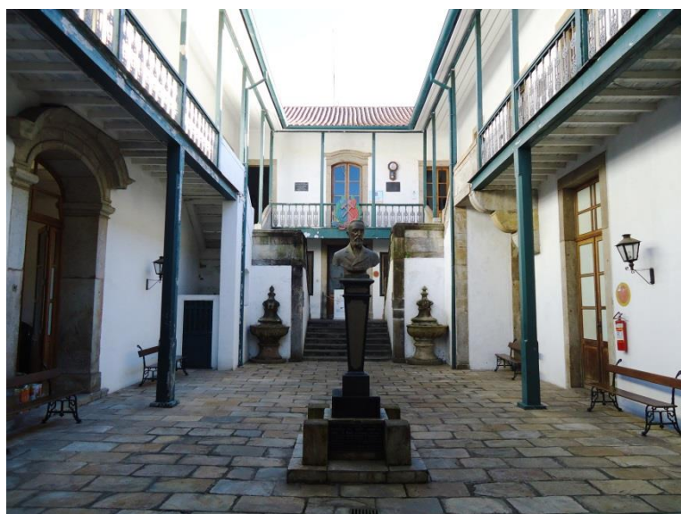
FIGURA 11 - Vista do pátio interno do Palácio dos Governadores, década de 2010.
