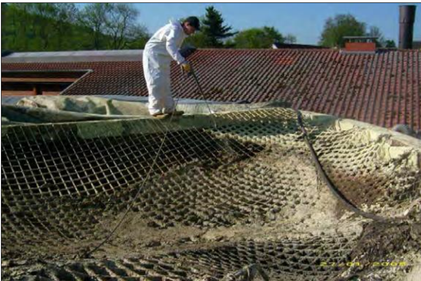
Figura 2.15 – Limpeza da malha suporte para remoção do enxofre precipitado.
