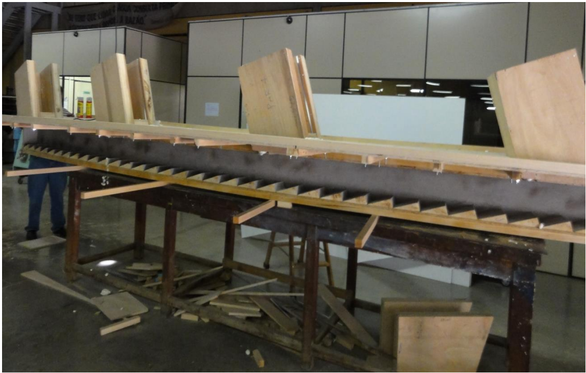
Figura 4.10 -Trecho curvo da galeria de encosta com as torres 03, 04, 05 e 06 – fase de construção.
