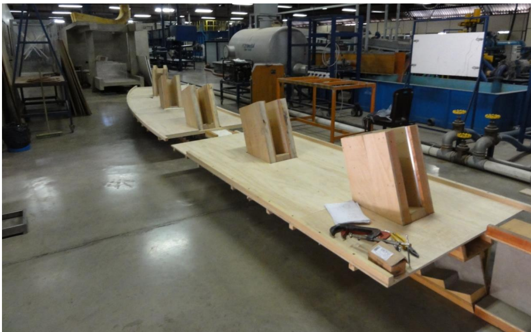
Figura 4.11 -Trechos reto e curvo da galeria de encosta – fase de construção.
