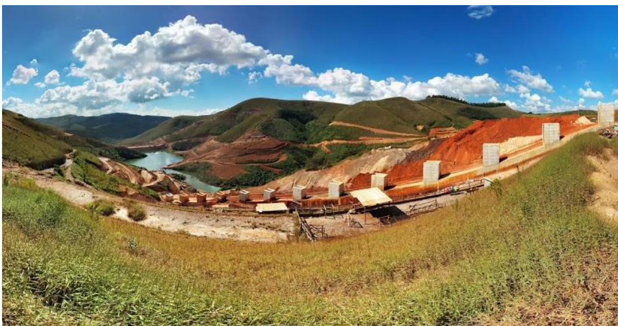
Figura 1.8 - Implantação do sistema extravasor operacional da barragem de rejeitos Forquilha IV - vertedouro tipo flauta de concreto armado.
