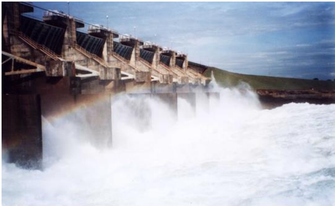
Figura 3.6 -Ressalto hidráulico formado na UHE de Porto Colômbia, vazão de 4000 m 3 /s e número de Froude ( Fr_1 ) igual a 3,88.
