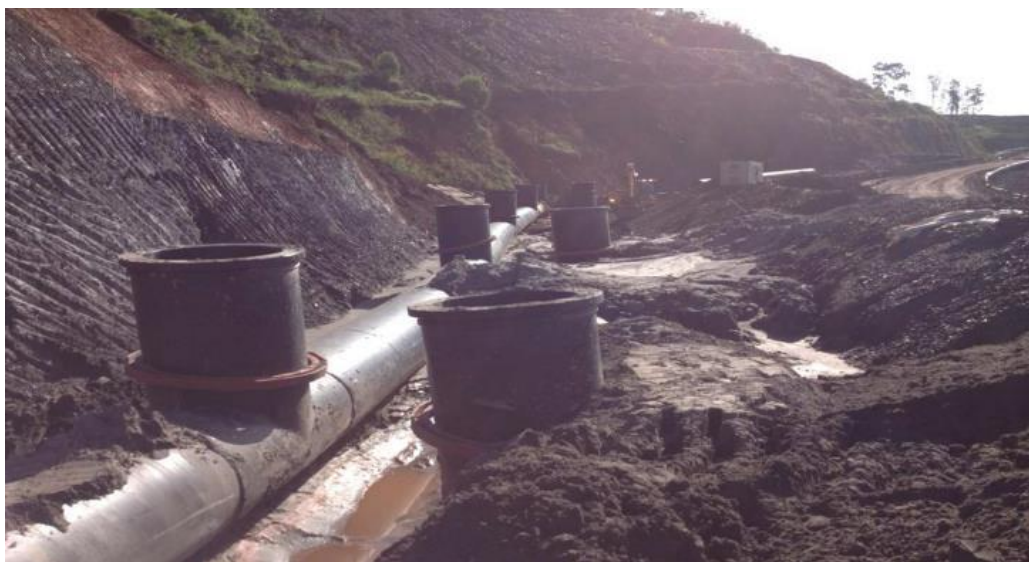
Figura 1.9- Implantação de um vertedouro tipo flauta, composto por duas linhas de tubo de PEAD. Barragem localizada no município de Mariana, Minas Gerais.
