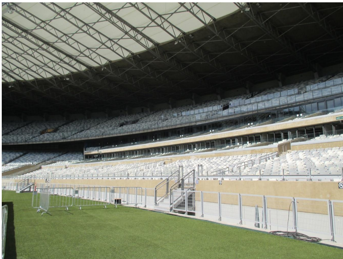
FIGURA 10 – Imagem interna do “novo” Mineirão 113
