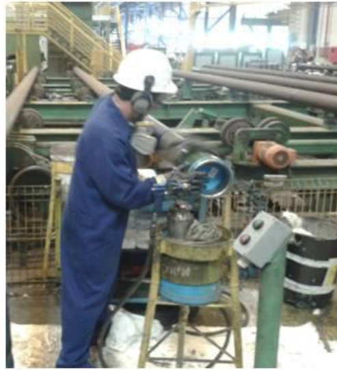
Figura 25 – Limpeza do tubo.
