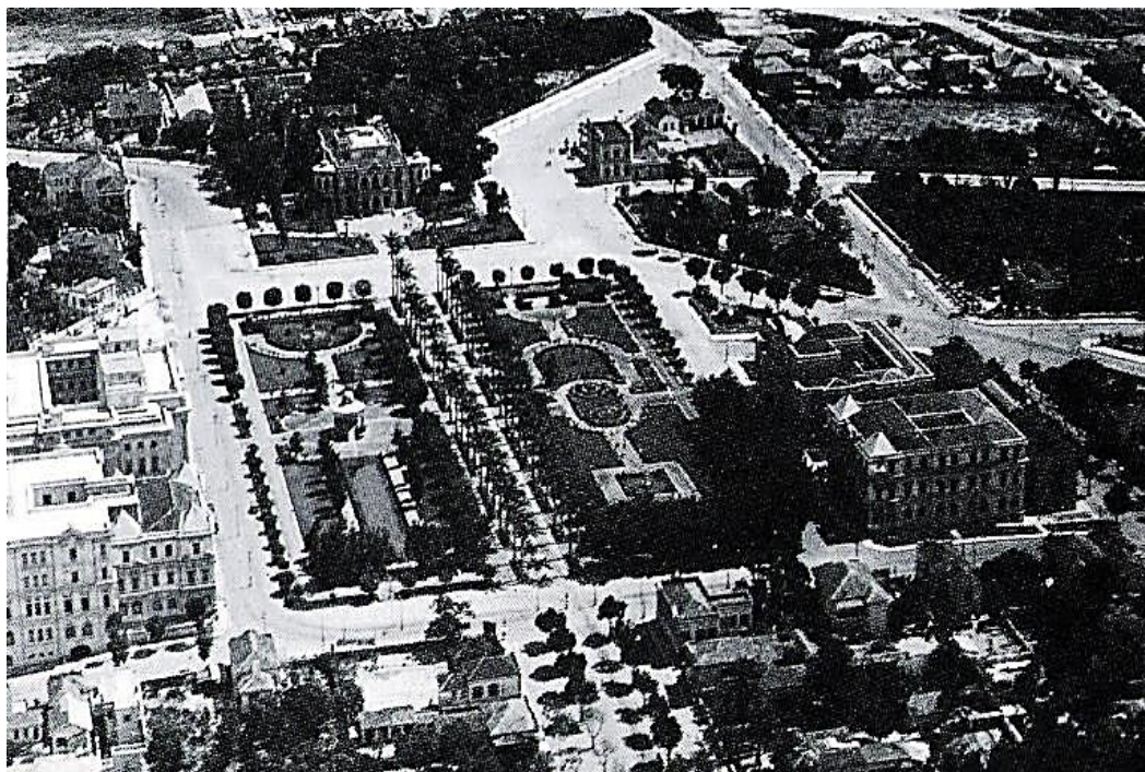
Figura 42 – Praça da Liberdade: vista aérea (década de 1930).
