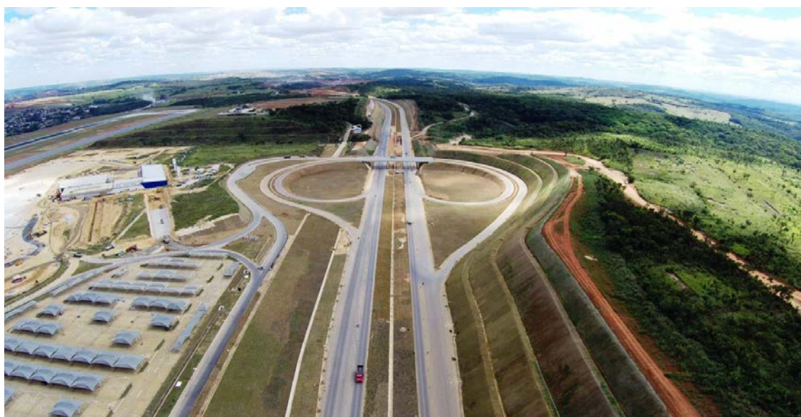
Foto 3: Morfologia Espacial da conclusão de 95% da obras de terraplanagem e intervenções na LMG800 e MG 424 no entorno do AITN, sentido Belo Horizonte-Confins, 2014.
