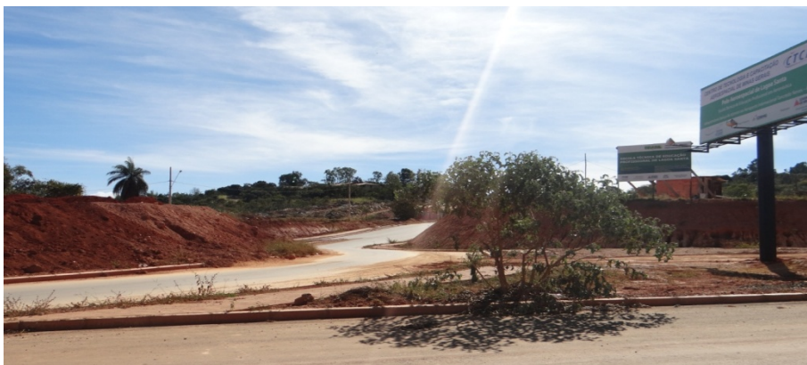
Foto 35: Obras do CTCA.
