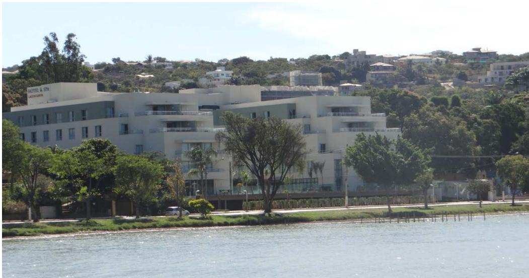
Foto 31: Hotel SPA Lagoa Santa, construído e aprovado na orla da Lagoa Santa, depois de polêmica, através de Termo de Ajustamento de Conduta.
