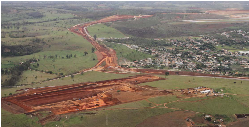
Figura 28 Obras de Terraplanagem LMG 800 e Fashion City, Pedro Leopoldo, 2013
