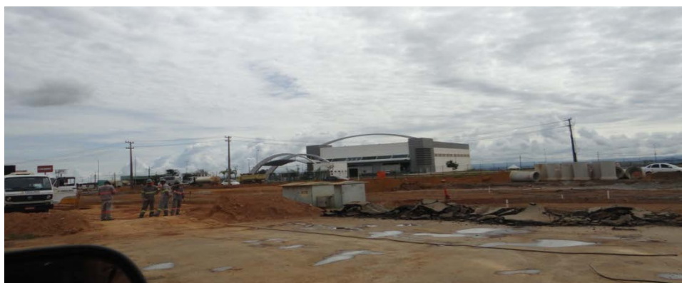
Foto 13: Aeroporto Indústria e LMG800 em obras.
