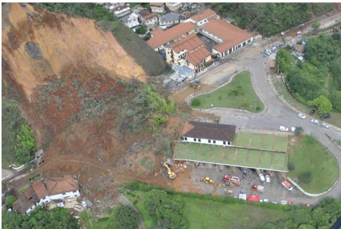
Figura 3 – Vista aérea da encosta que deslizou sobre a rodoviária de Ouro Preto
