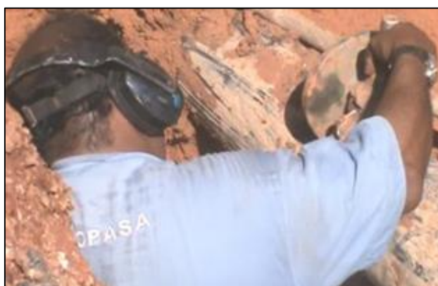
Figura 3 - Trabalhador na posição de pé, realizando o corte com a esmerilhadeira.
