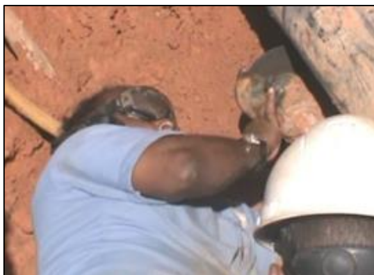
Figura 3 - Trabalhador na posição de pé, realizando o corte com a esmerilhadeira.
