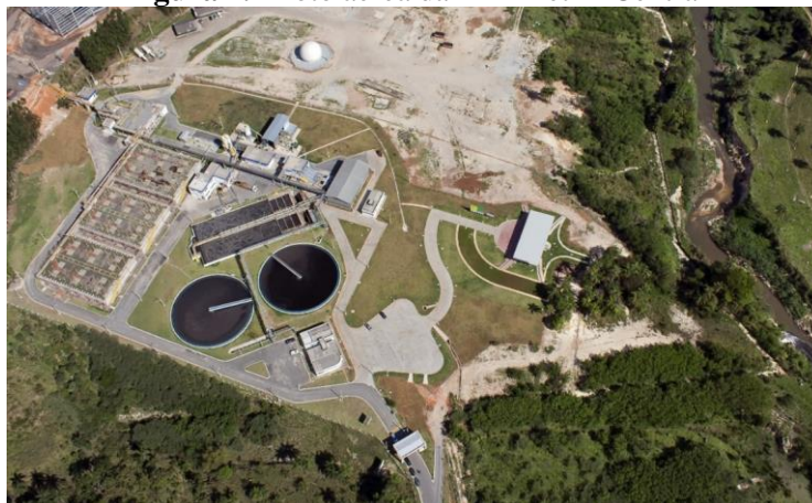
Figura 4.2 Foto aérea da ETE Betim Central
