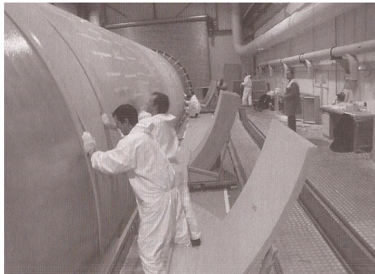
Figura 3. Operação de colagem do isolamento térmico de um tanque criogênico (HART-SMITH, 2011)
