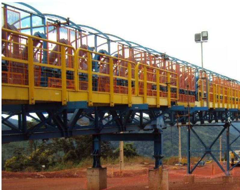
FIGURA 2.26 - Estrutura tipo ponte treliçada (Sandvik MGS S/A)
