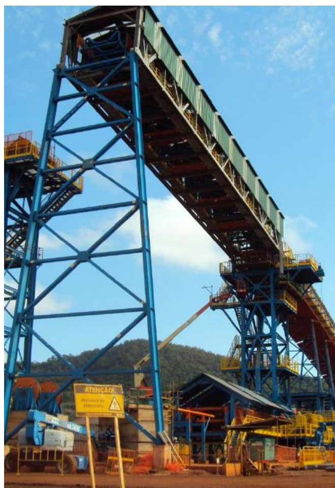
FIGURA 2.27 - Estrutura tipo galeria (Sandvik MGS S/A)
