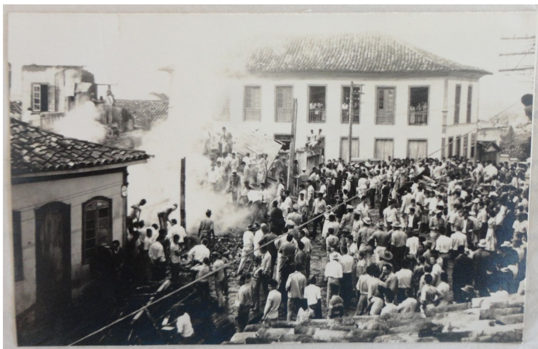
Figura 34: Incêndio na Casa Tiradentes (agosto de 1958). In ACI/IPHAN/Seção Rio de Janeiro. Diamantina. Pasta: Tombamento do Conjunto Arquitetônico de Diamantina – Processo 64-T-38.
