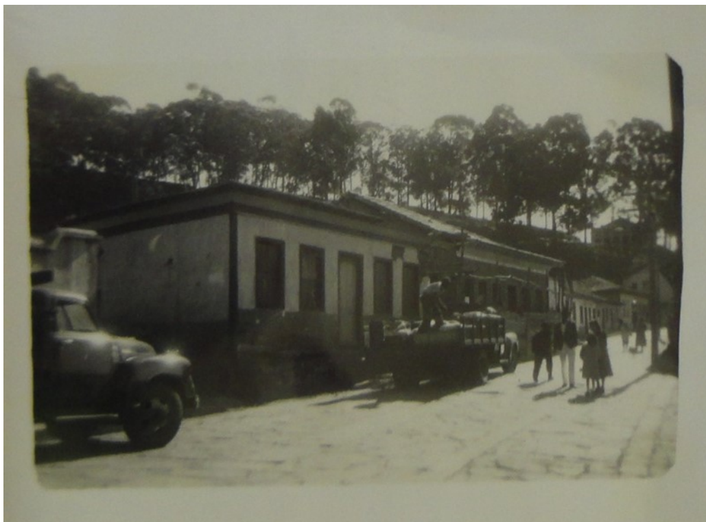
Figura 35: Casas da Firma Coelho & Irmão. (13/07/1949). In: CDI/IPHAN/MG. Diamantina. Pasta: Rua Augusto Nelson (1947-1992); Caixa: 150.
