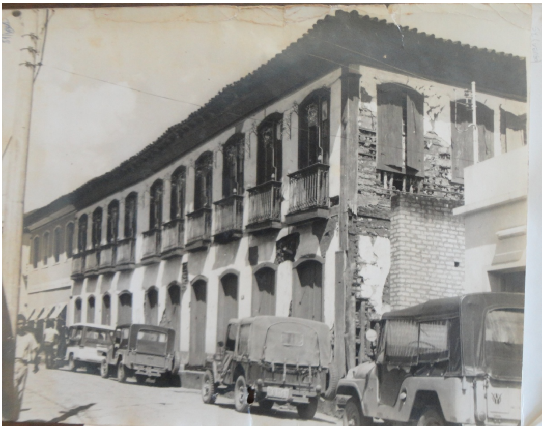
Figura 26: Sobrado onde nasceu Pedro Lessa (1972). ACI/IPHAN/Seção Rio de Janeiro. Tombamento Conjunto Arquitetônico do Serro - Processo 65-T-38.
