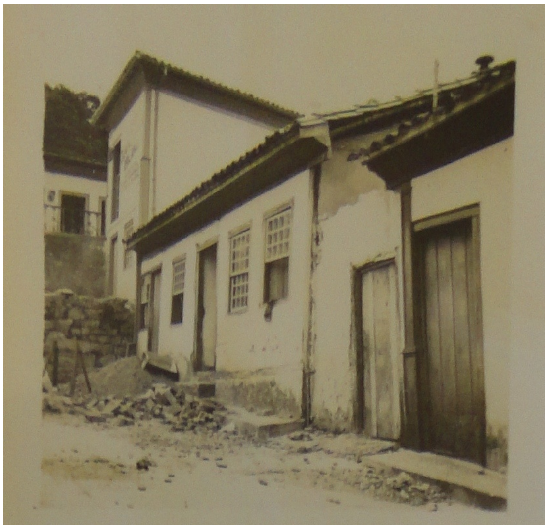
Figura 14: Residência de Maria Aguillar (abril de 1954). In: CDI/IPHAN-MG. Diamantina. Pasta: Logradouro/Proprietários/Administrativo: pedidos de aprovação de obras e recursos - 1953-1959 e 1940-90; Caixa: 183.
