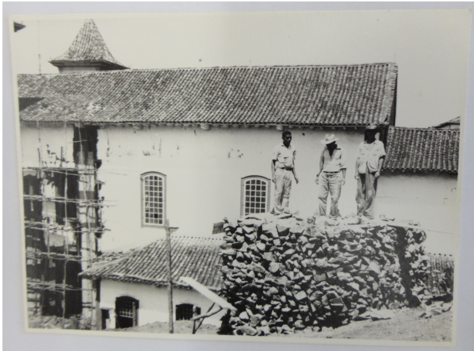
Figura 30: Operários na Matriz de Nossa Senhora da Conceição (1959). In: CDI/IPHAN-MG. Serro. Pasta: Matriz de Nossa senhora da Conceição.
