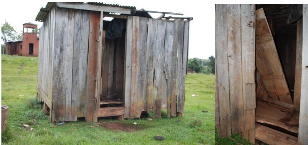
Foto 04. Fonte: Arquivo próprio (2012), modelo de cadeia interna, ao fundo parte de uma igreja católica abandonada, construída nos anos 1950 37 .
