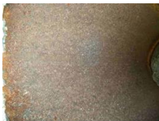
Figura 5. 5 - Carretel da amostra 2, posição 90° (solda).
