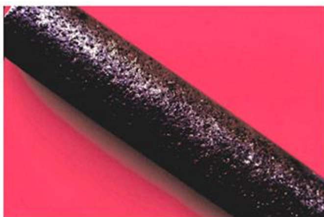
Figura 3. 11 - Corrosão por pites em tubo de aço carbono (GENTIL, 2003).
