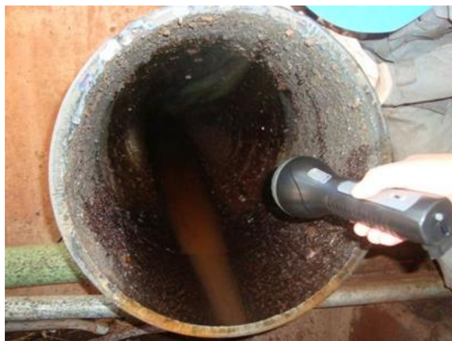
Figura 5. 106 - Parte interna da tubulação de descarga/recalque da EB2.
