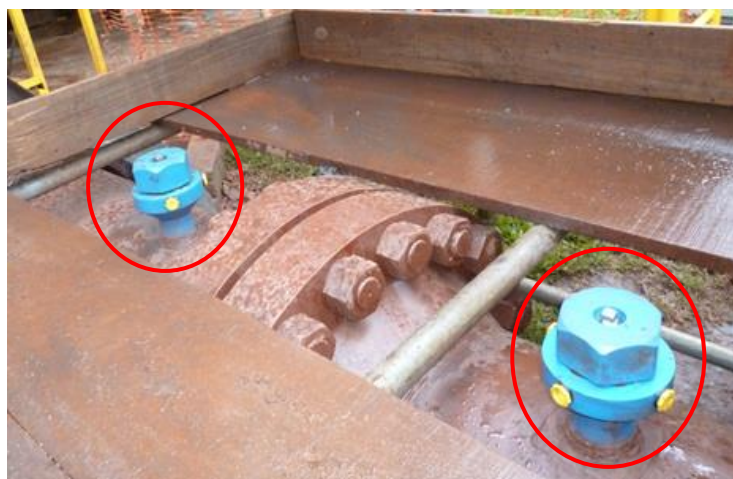
Figura 5. 151 - Instalação de cupom e biocupom.
