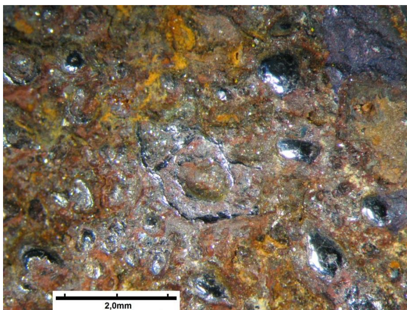
Figura 5. 80 - Crosta de corrosão da tubulação de EB1 com tubérculos.
