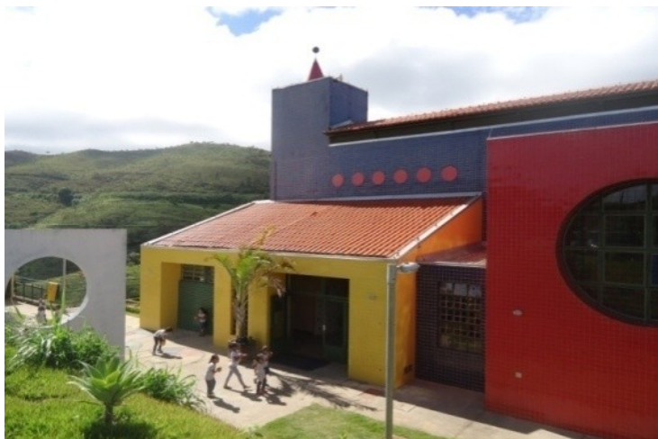
IMAGEM 8: Foto fachada UMEI Taquaril Fonte: arquivo pessoal da pesquisadora
