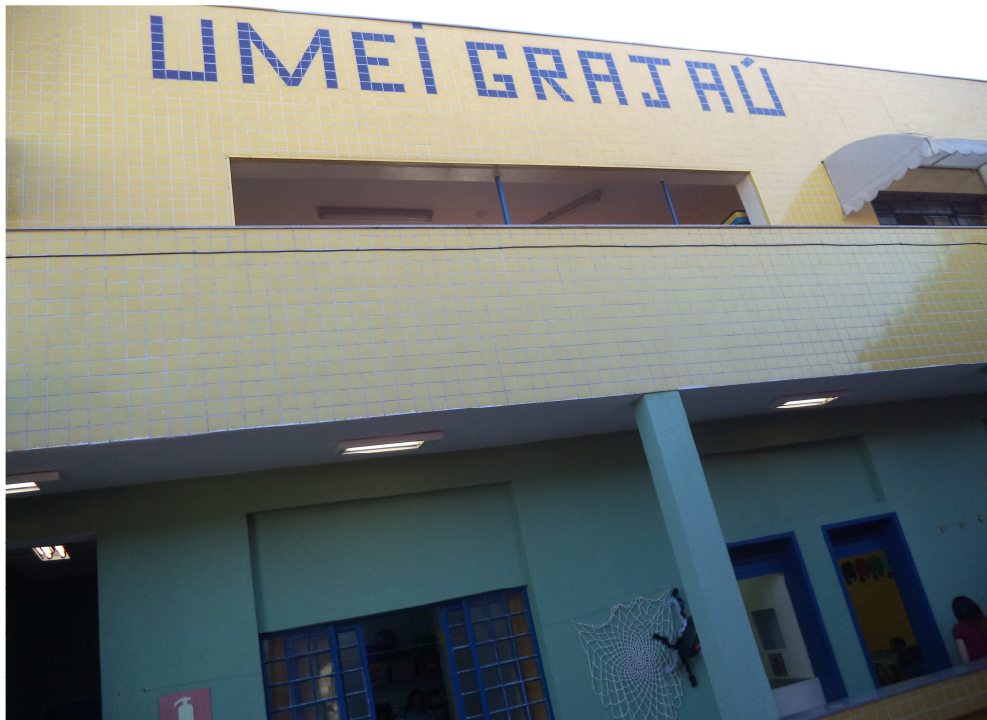
Figura 3: Faixada interna escola Fonte: arquivo pessoal da pesquisadora
