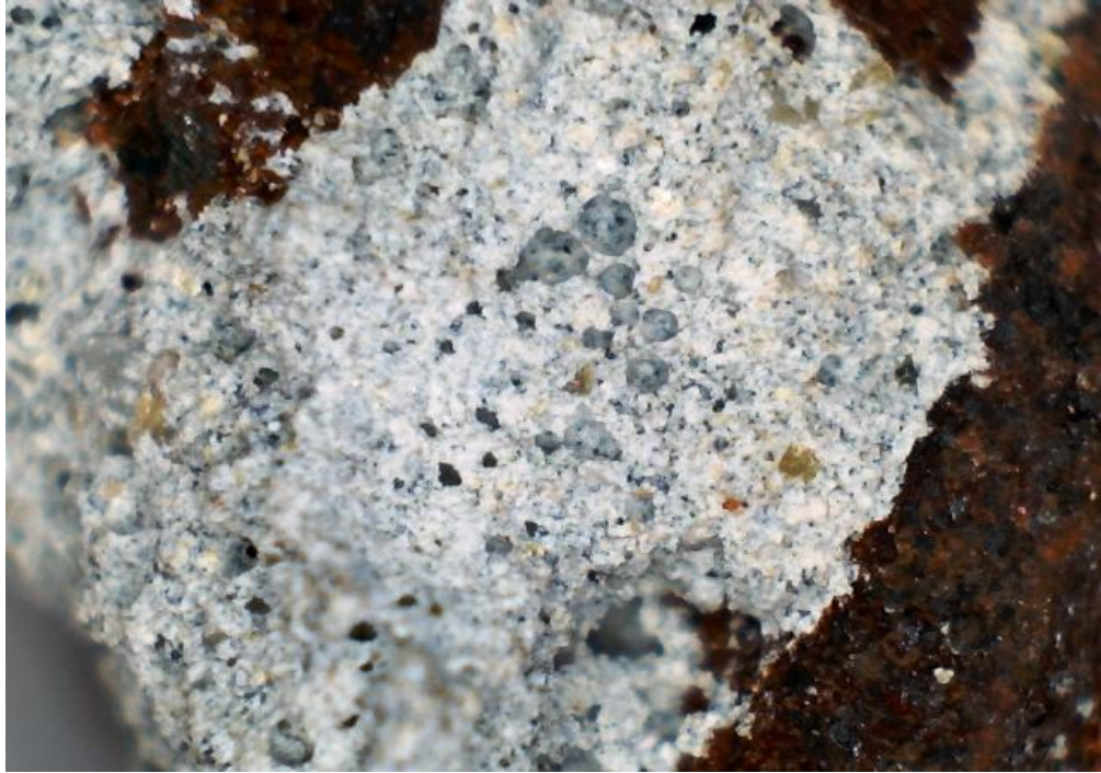
Figura 5.2.3.3.19 - Interface do concreto com aço da armadura. Rede poros interconectados, corpo de prova referência armado 8. Atacado 150 dias Ampliação 800X com lupa estereoscópica.
