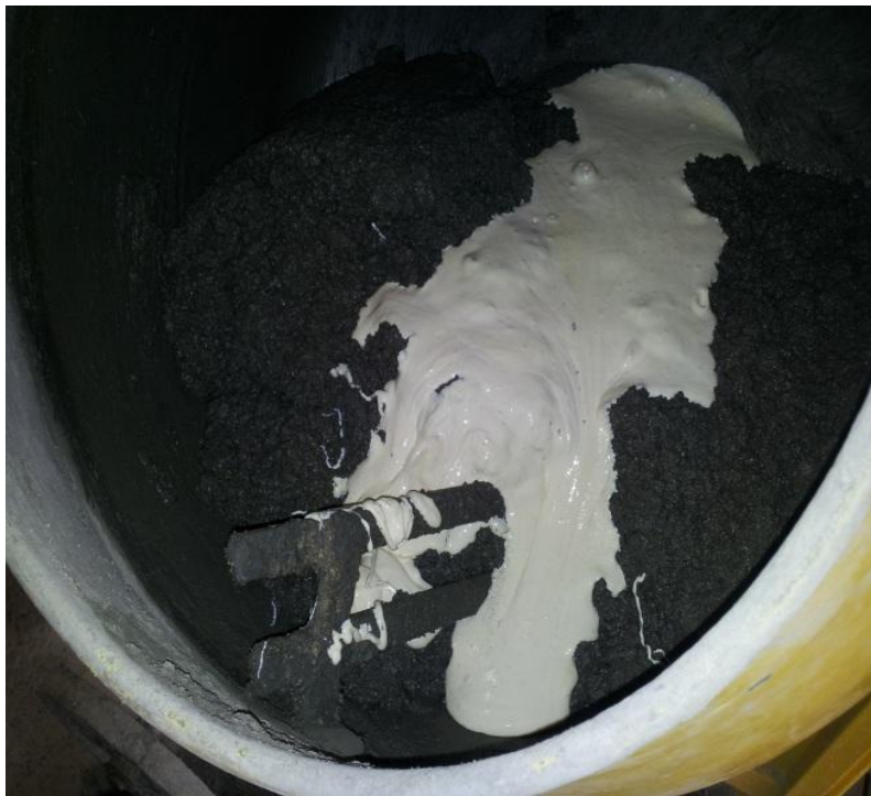
Figura 4.6.2.4 - Mistura da resina ao concreto, juntamente com a última parte da água.
