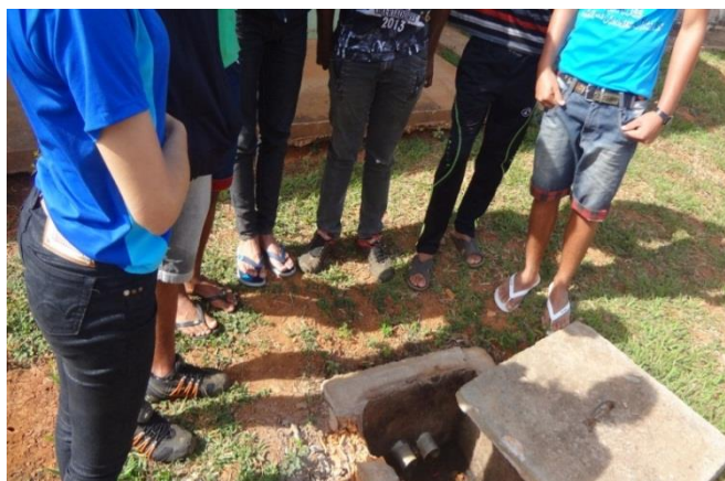
Figura 6. Inspeção de caixa de gordura.
