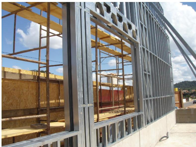
Figura 3.4 Detalhe execução painel estrutural duplo.
