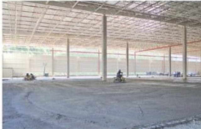
Figura 4.9 - Sub-base tratada com brita graduada simples, barras de transferência e início de acabamento na placa de concreto
