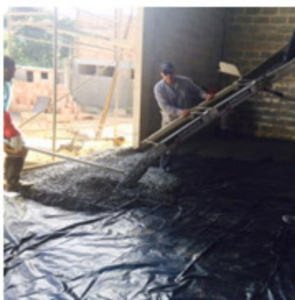
Figura 5.5 - Execução Piso Galpão obra em São José da Lapa – MG – Lançamento Concreto com Fibras
