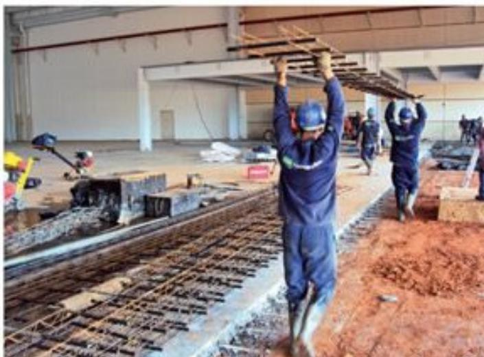
Figura 4.5 - Montagem das fôrmas e das barras de transferência com os espaçadores metálicos
