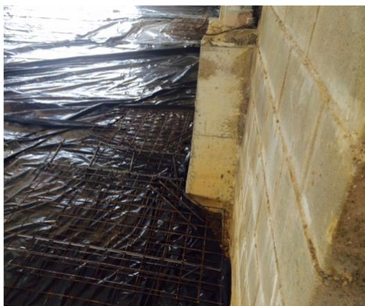
Figura 5.4 - Execução Piso Galpão obra em São José da Lapa – MG – Reforço Pilares com Telas
