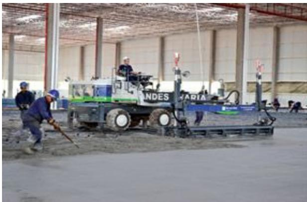
Figura 4.7 - Lançamento e espalhamento do concreto com o Laser Screed
