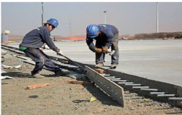
Figura 4.8 - Retirada das fôrmas de madeira nas laterais com barras de transferência de carga
