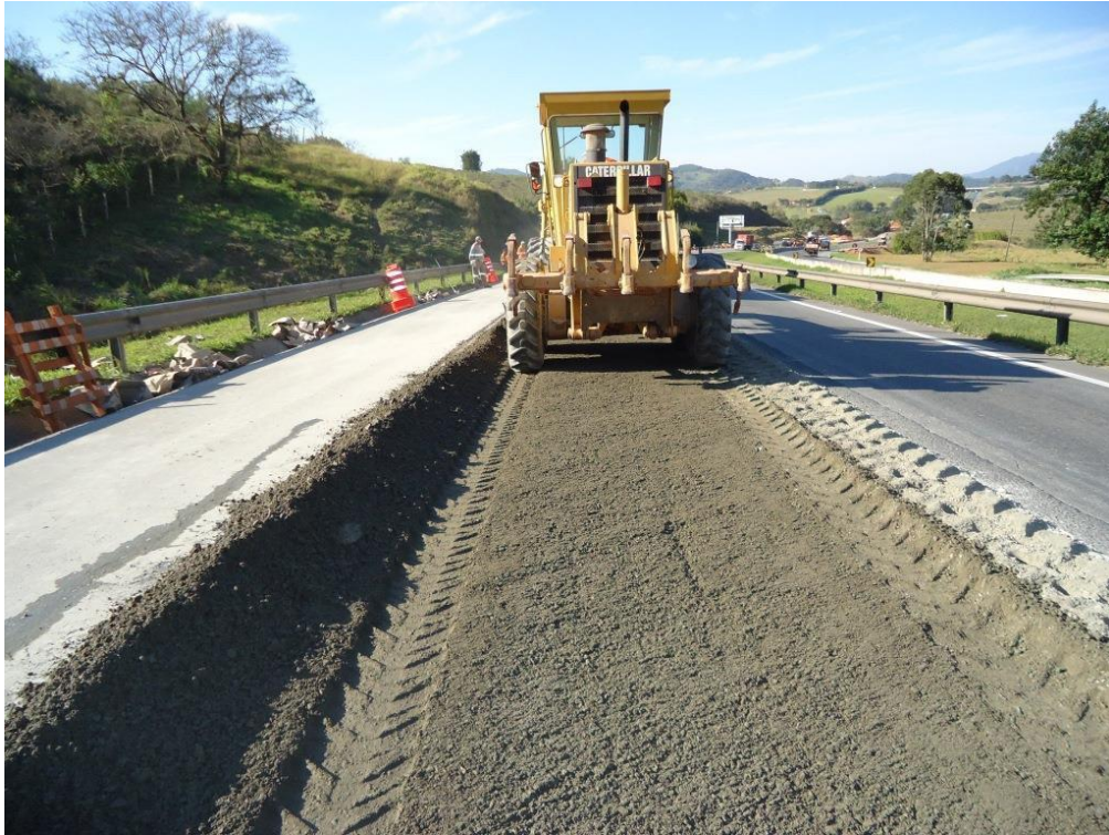
Figura 26 - Lançamento do material reciclado de base
