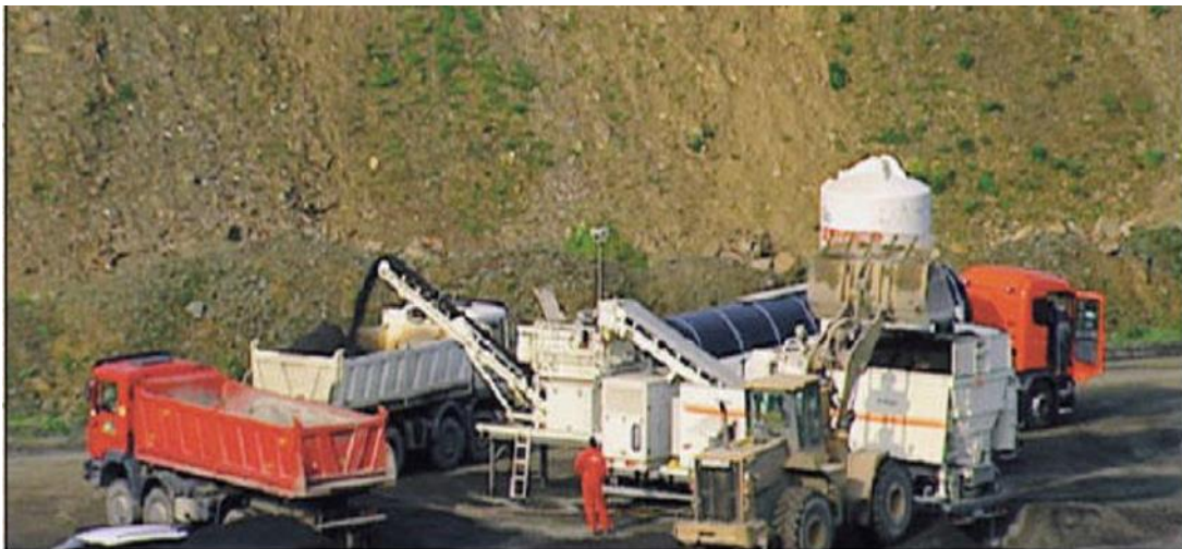
Figura 14 - Reciclagem a frio em usina
