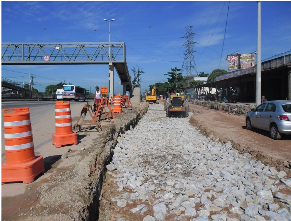
Figura 33 - Reforço da capa do subleito com rachão
