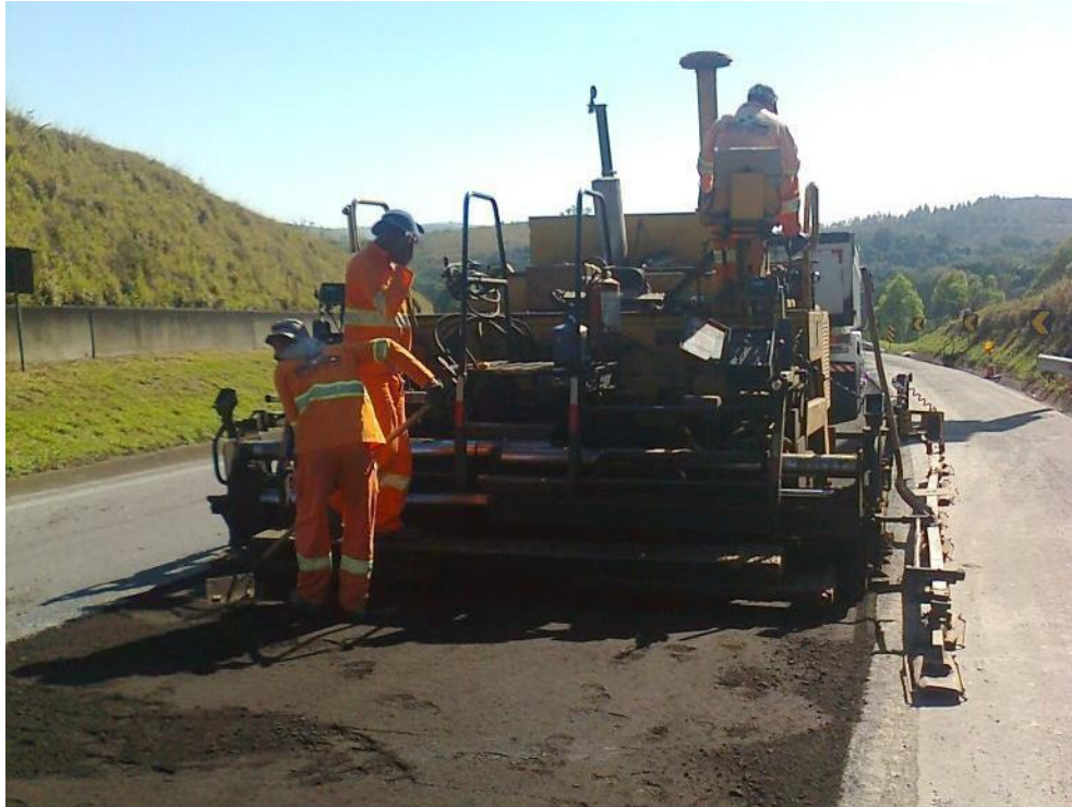
Figura 23 - Lançamento da segunda camada de pavimento - CBUQ (não reciclado)
