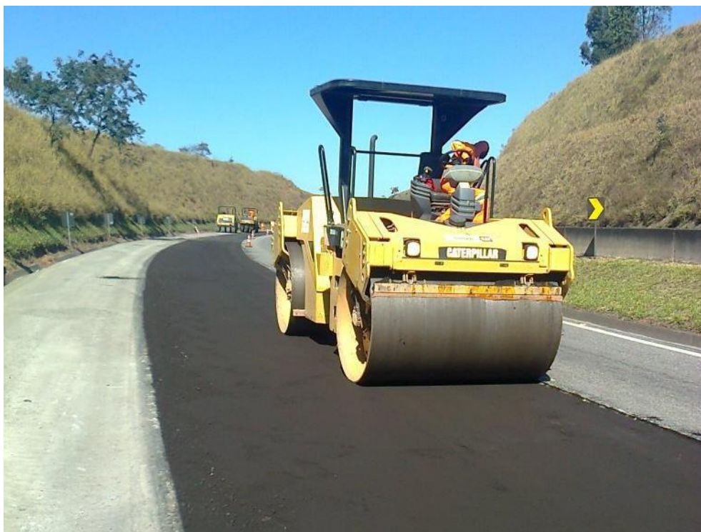
Figura 31 - Finalização e compactação final do pavimento
