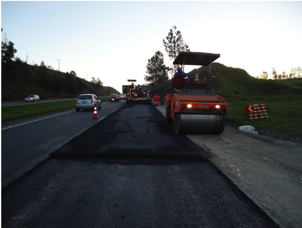
Figura 30 - Lançamento do material final, não reciclado do capeamento - CBUQ
