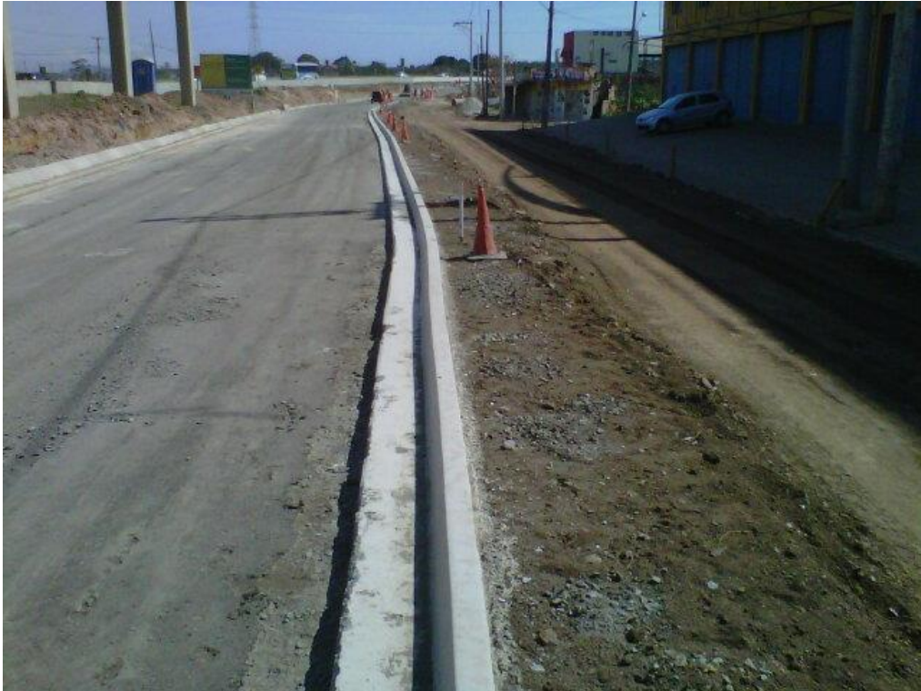
Figura 34 - Finalização da base com material reciclado com adição de cimento (processo de cura)
