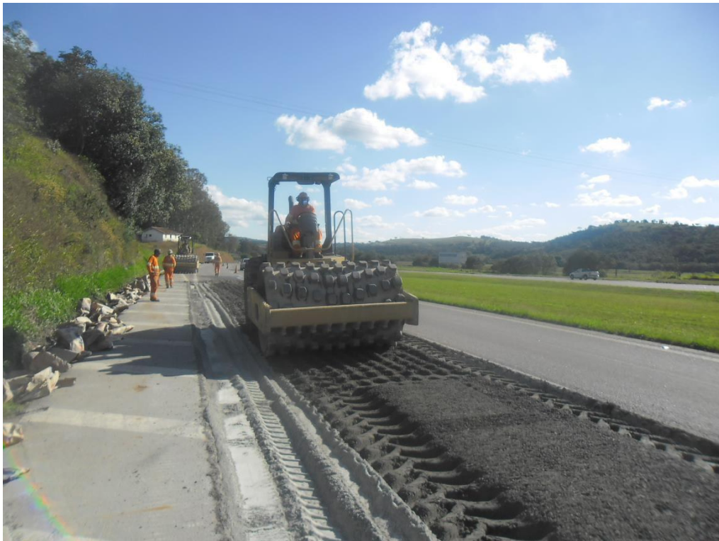
Figura 27 - Compactação de base
