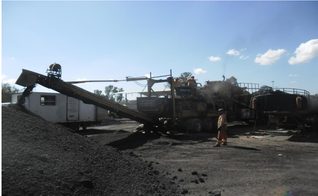
Figura 21 - Despejo de material fresado na Usina para reciclagem
