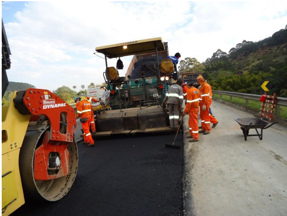
Figura 28 - Lançamento do material reciclado em central fixa da primeira fase do capeamento
