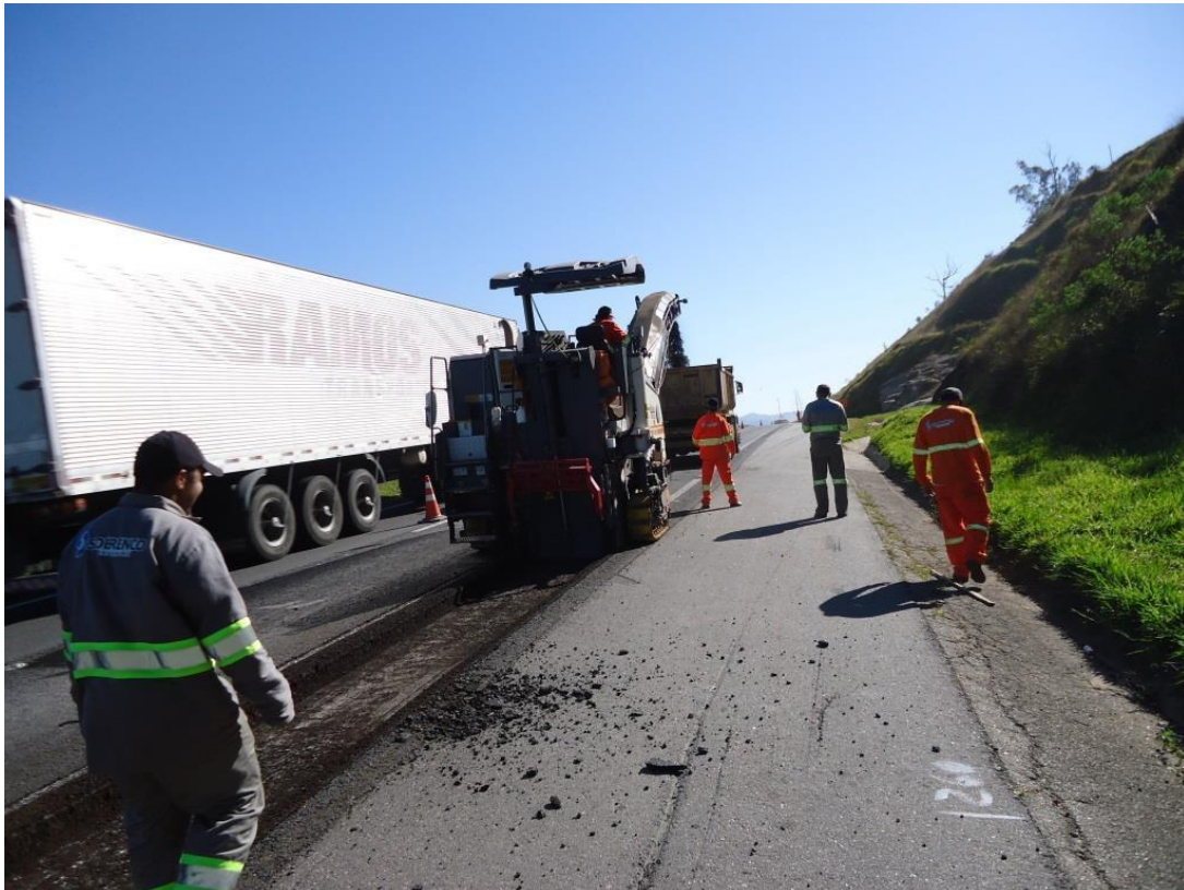
Figura 20 - Fresagem do capeamento
