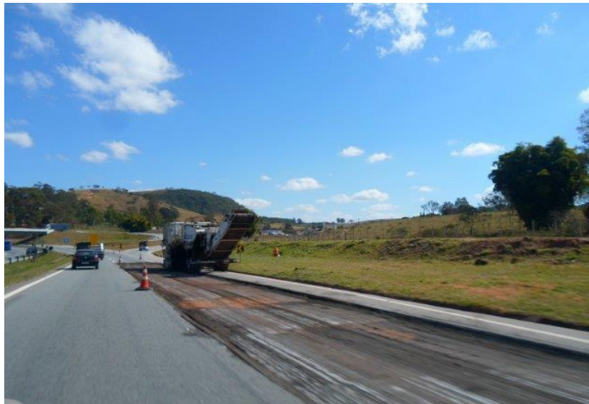
Figura 24 - Fresagem do capeamento
