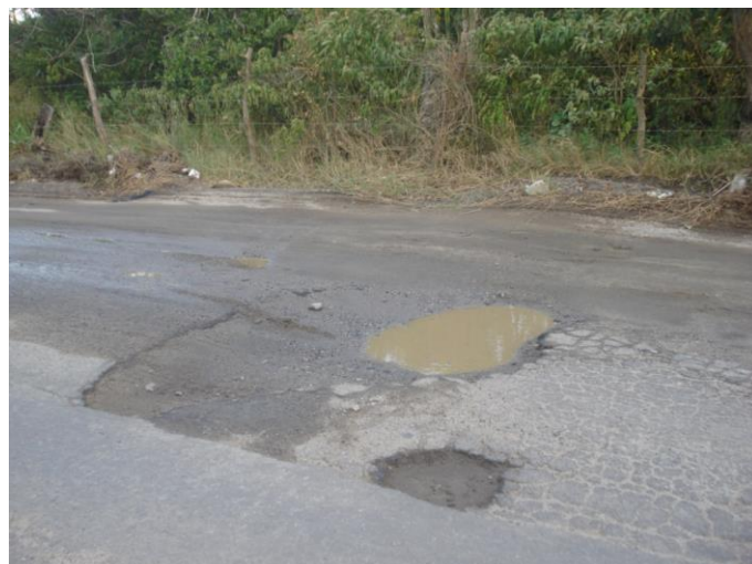
Figura 9 - Panela ou buraco associado ao tráfego
