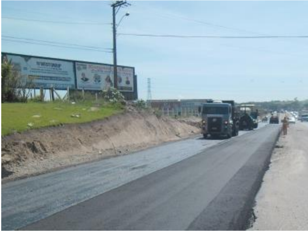
Figura 36 - Aplicação da segunda camada do capeamento com CBUQ
