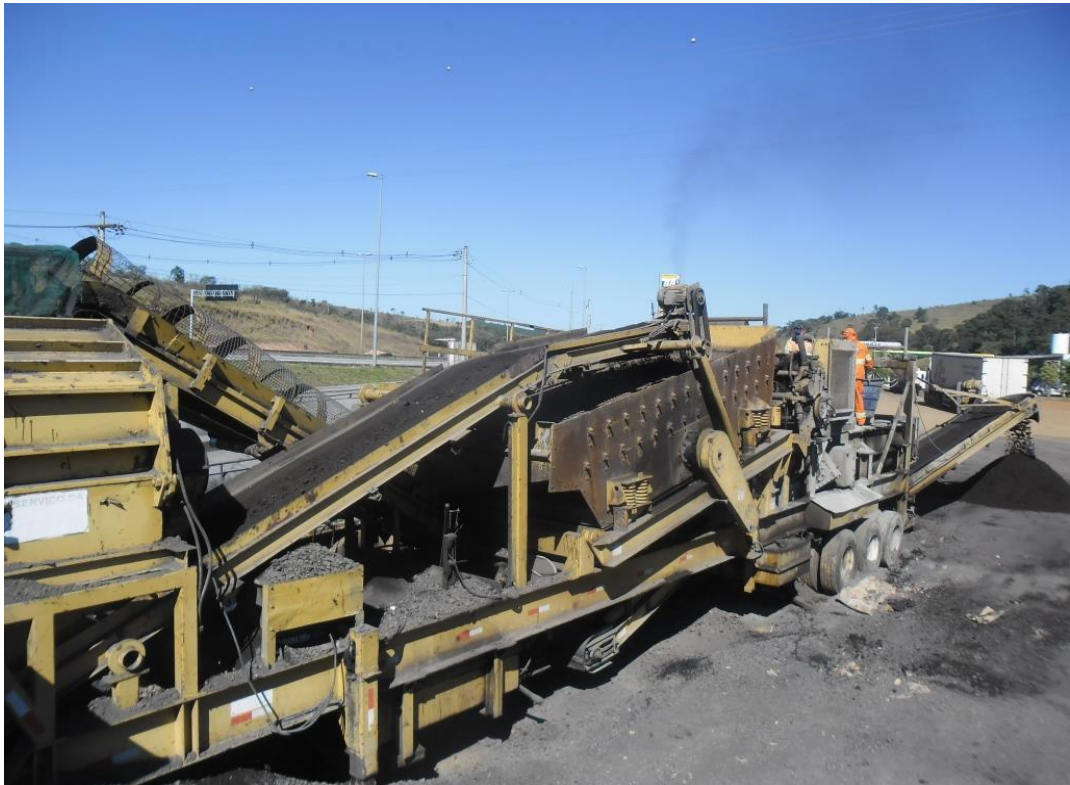
Figura 25 - Maquina de reciclagem in situ do material de base
