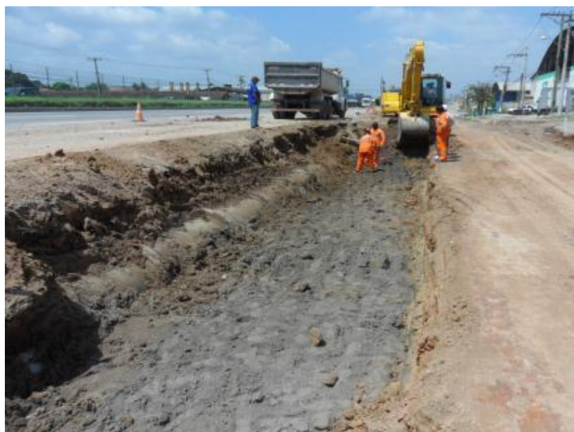
Figura 32 - Remoção do material de base e subleito
