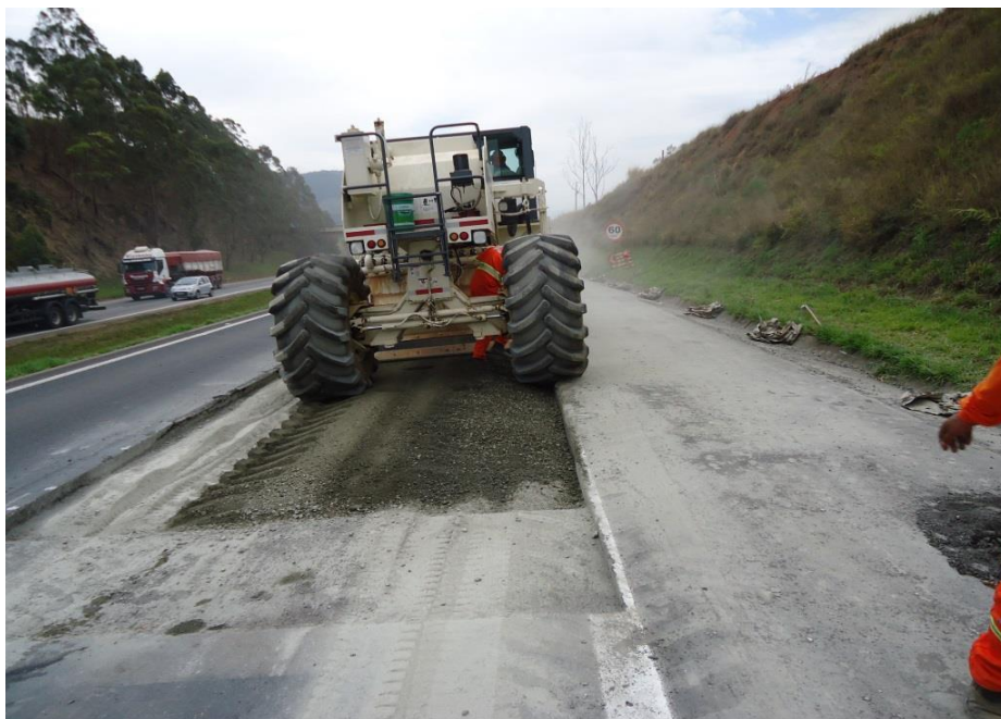
Figura 22 - Lançamento e compactação da primeira camada do capeamento com material reciclado
