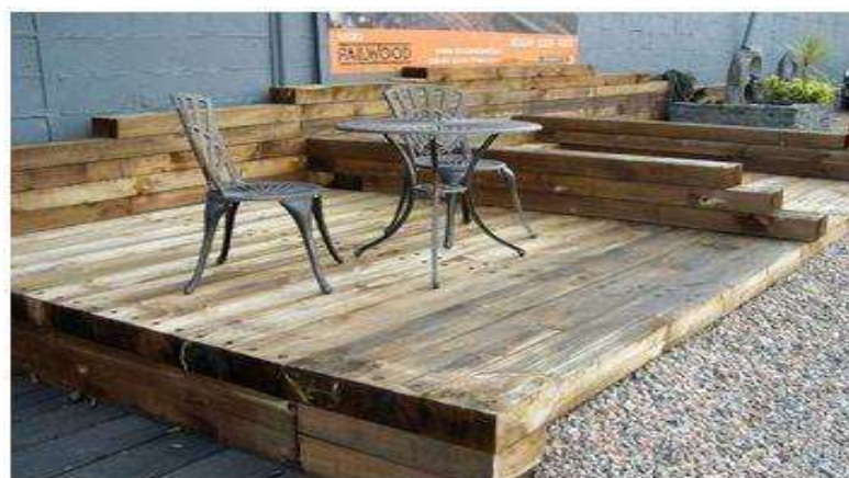
Figura 12 – Utilização de dormentes em deck
