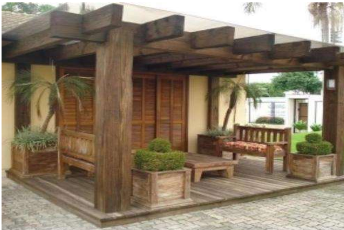
Figura 8 – A utilização de dormentes em casas de campo
