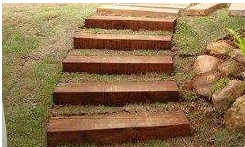
Figura 6 – Degrau de madeira decorativa
