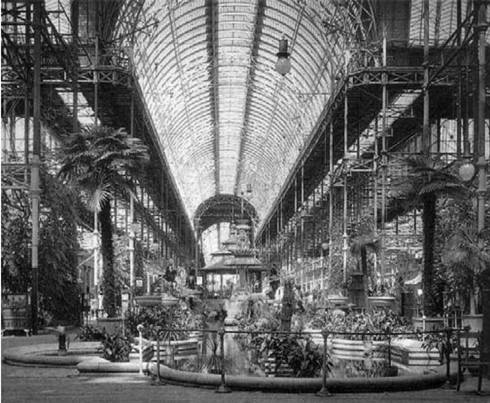
FIGURA 2: Edifício Crystal Palace
