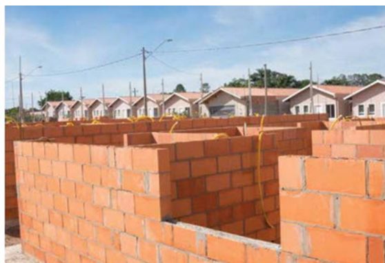
Figura 4.4 - Alvenaria estrutural – redução da geração de resíduos
