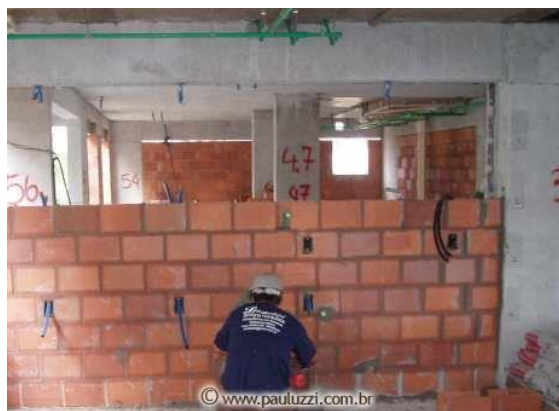
Figura 4.5 - Alvenaria modular em estrutura convencional com projeto executivo de alvenaria
