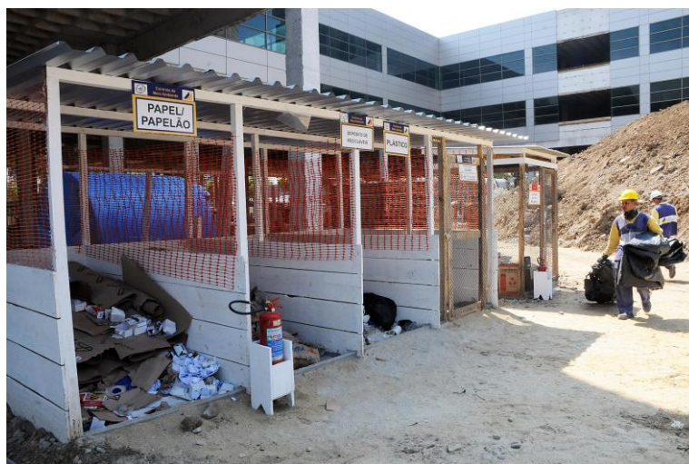
Figura 5.1 Segregação de resíduos sólidos de RCC em canteiro de obras com metas à certificação LEED
