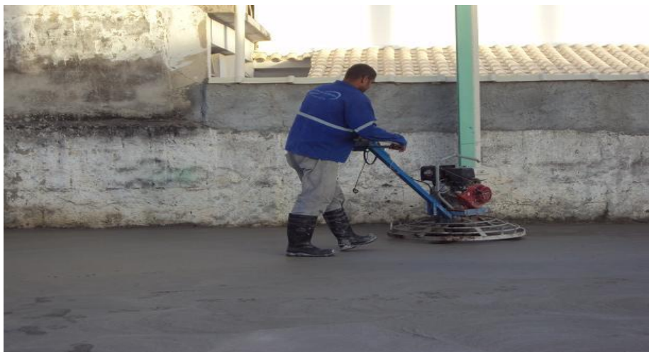
Figura 6 - Polimento de Concreto Acabamento Mecânico.
