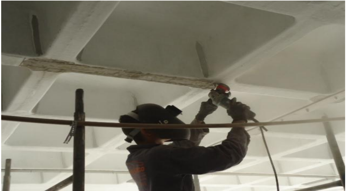
Figura 28 – Lixamento Da Estrutura De Concreto.
