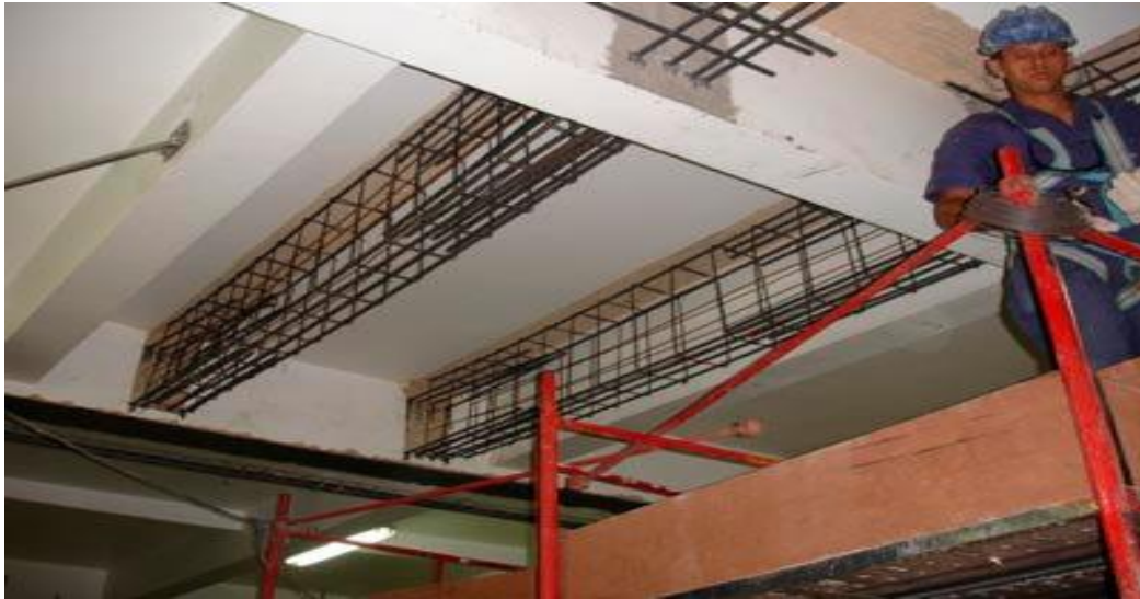
Figura 3 - Reforço de Concreto, Processo de Encamisamento
