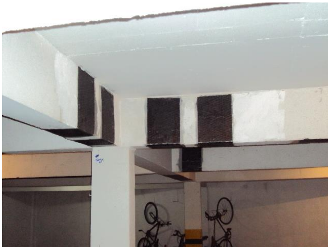
Figura 25 – Reforço com Chapa Metálica
