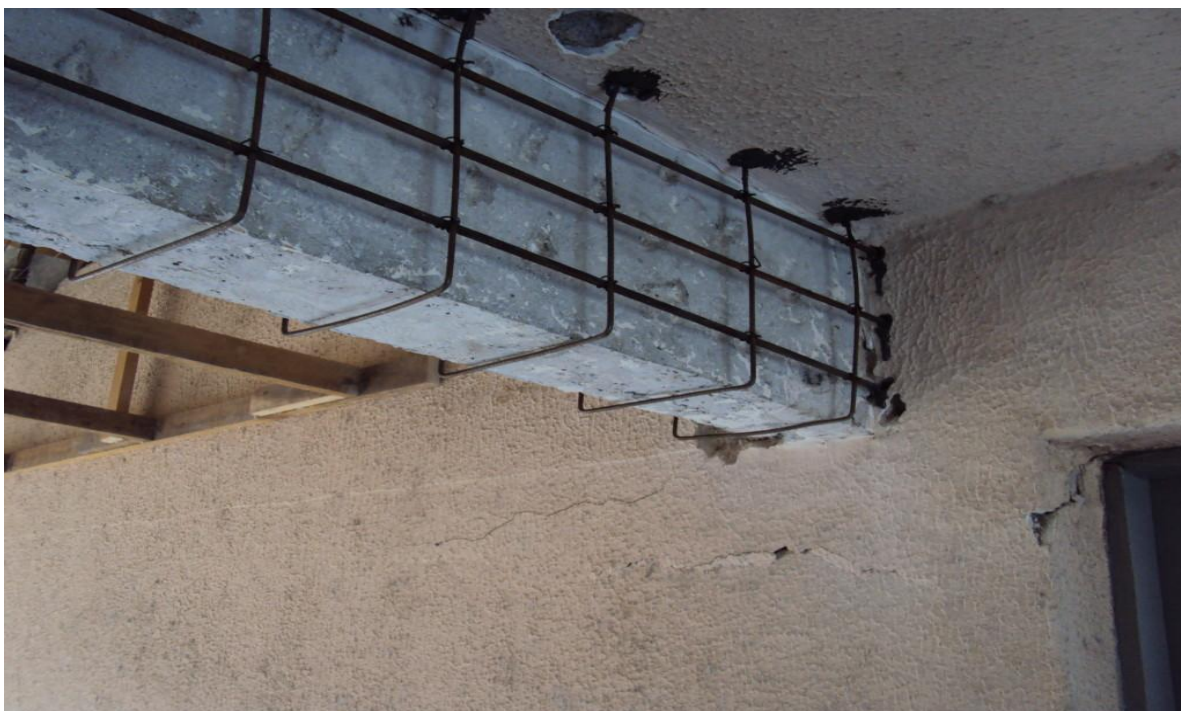
Figura 24 – Reforço Em Concreto Com Armadura
