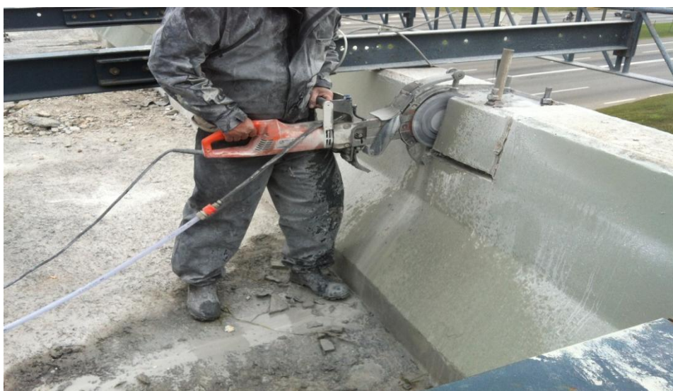
Figura 10 - Corte De Superfície De Concreto
