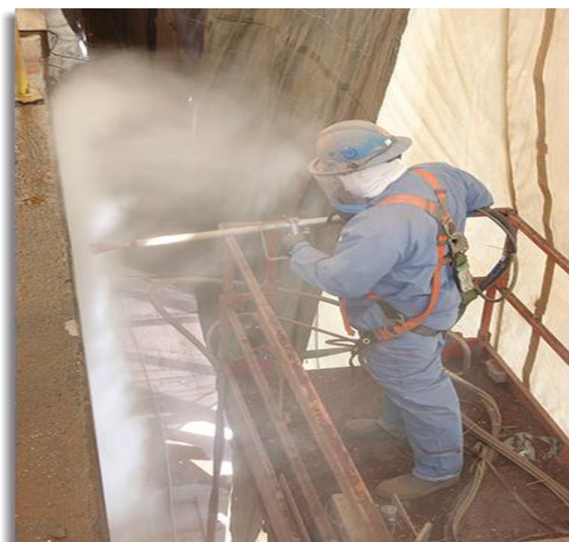
Figura 7 - Realização do Hidrojateamento de Areia
