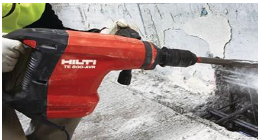
Figura 9 – Apicoamento Mecânico.
