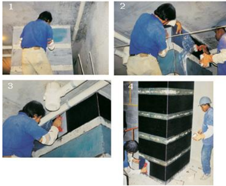
Figura 27- Reforço De Pilar Com PFRC
