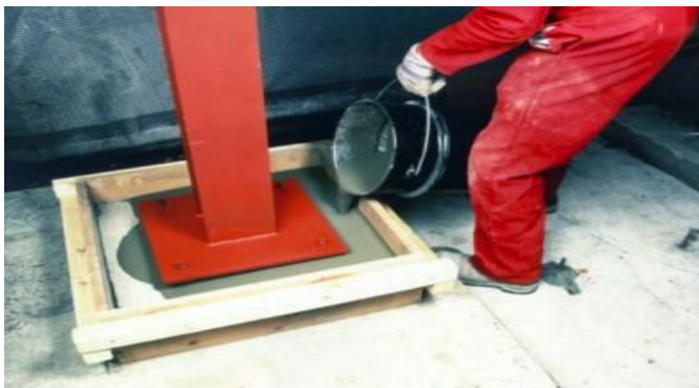
Figura 15 - Grautes Para Preenchimento De Nichos De Ancoragem E Reparos Estruturais Em Concreto
