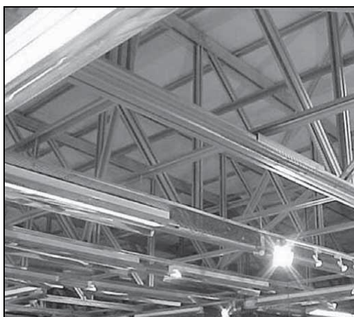
Figura 3.17 – Aplicação de treliças planas
