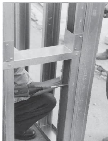
Figura 3.13 - Bloqueador e fita de aço galvanizado fixados ao painel
