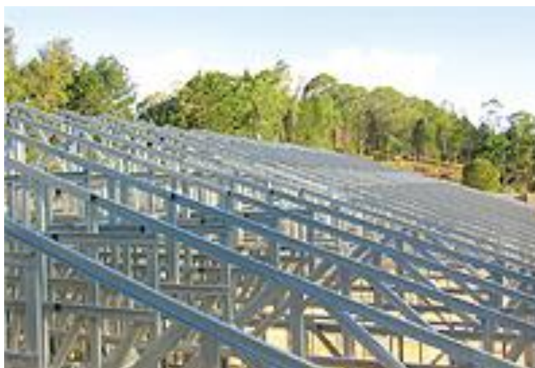
Figura 3.19 – Cobertura de residência com tesouras
