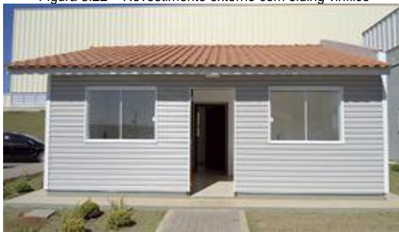
Figura 3.22 – Revestimento externo com siding vinílico
