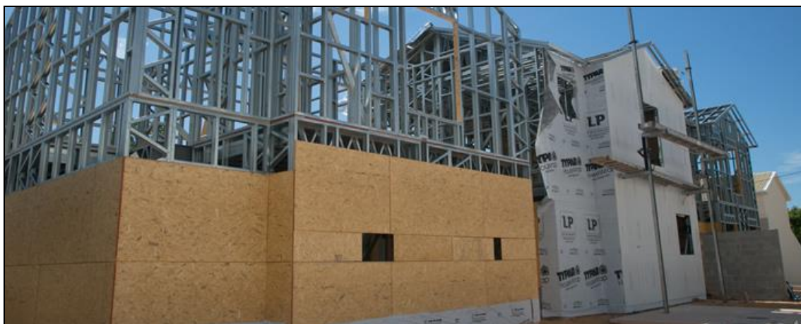
Figura 3.21 – Fechamento externo com placa OSB e impermeabilização
