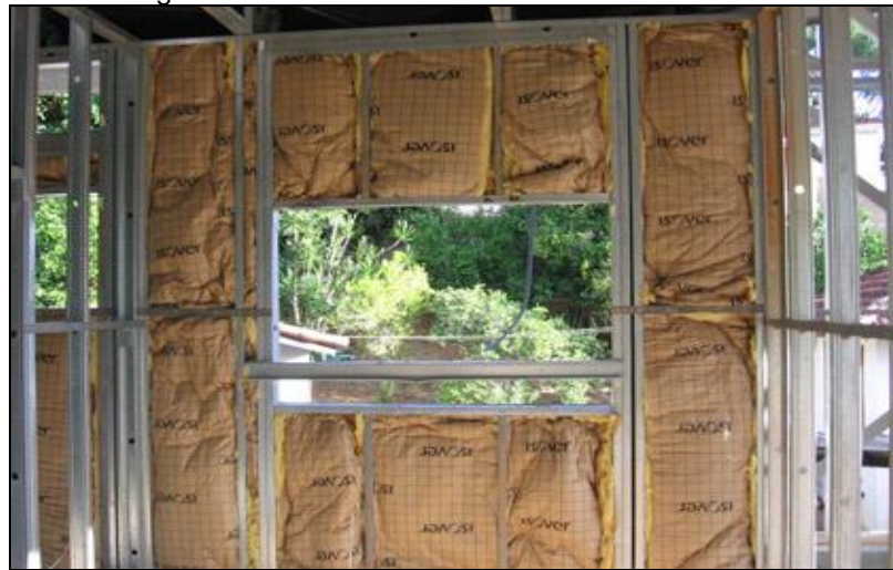
Figura 3.24 – Isolamento acústico com lã de vidro
