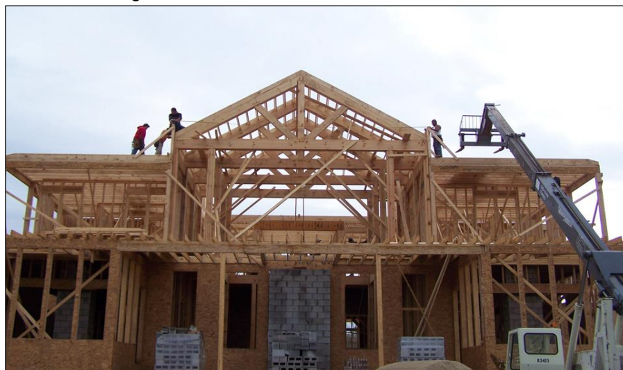
Figura 3.2 – Estrutura da casa em Wood Frame
