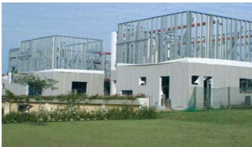
Figura 3.20 – Fechamento externo com placa cimentícia
