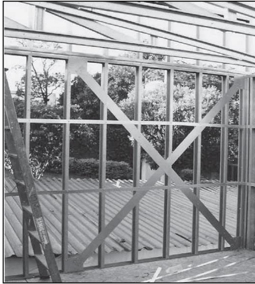
Figura 3.12 – Paineis com contraventamento em X
