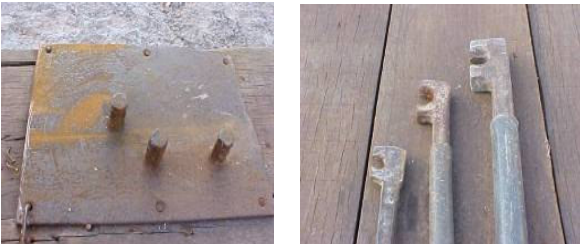
Figura 1.9 - Dobramento manual da armadura em canteiro (pinos e chaves) Fonte: BOTTURA & MELHADO, 2006
