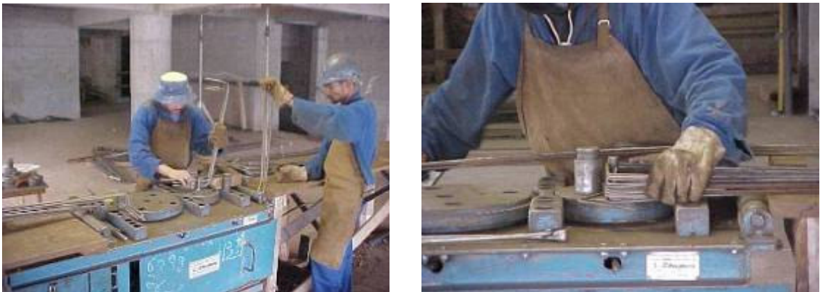
Figura 1.13 - Dobramento com equipamento hidráulico Fonte: BOTTURA & MELHADO, 2006
