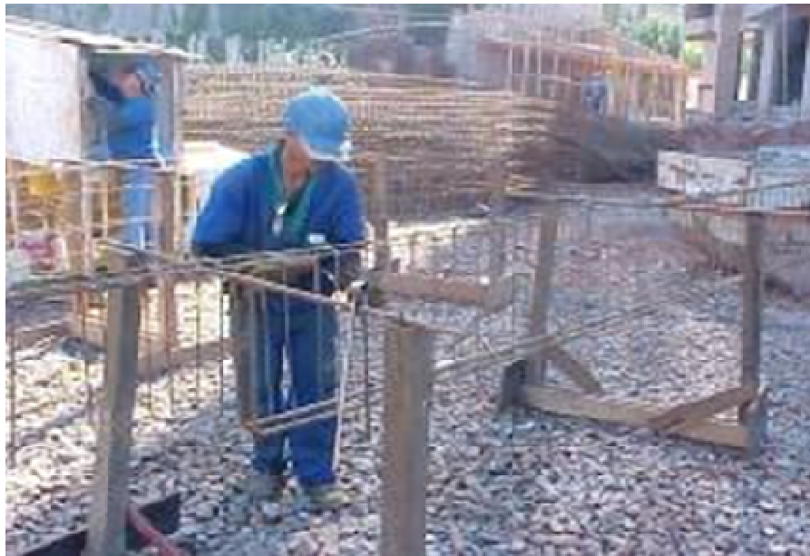
Figura 1.15 – Pré-montagem da armadura de viga Fonte: BOTTURA & MELHADO, 2006
