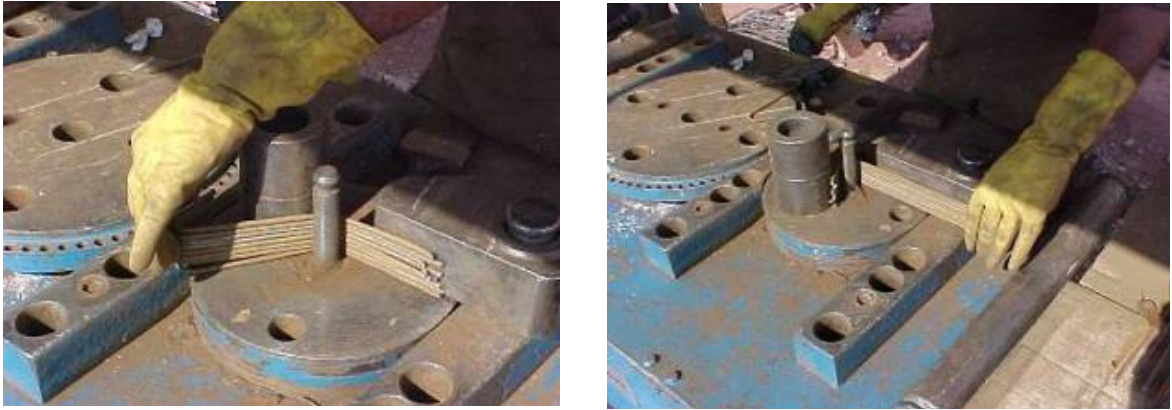
Figura 1.12 - Dobramento com equipamento hidráulico Fonte: BOTTURA & MELHADO, 2006
