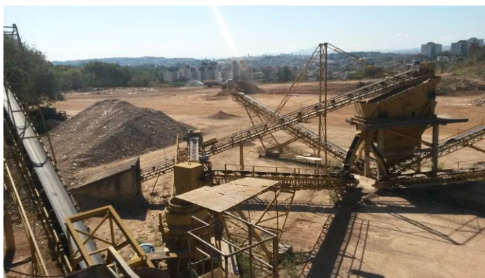
Figura 13- Equipamentos da estação de reciclagem de Belo Horizonte desligados
