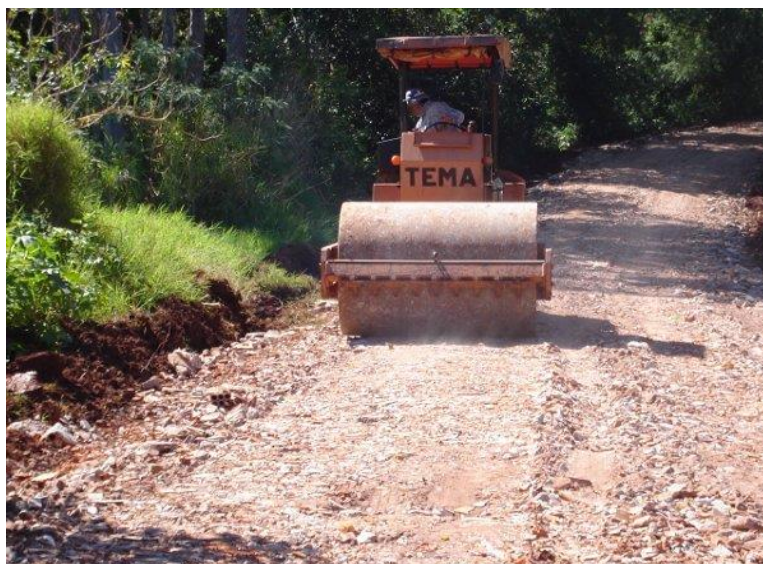
Figura 9 – Entulho sendo compactado.
