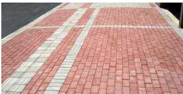
Figura 12- Passeio de uma farmácia em Blumenau SC, pavimento inter-travado composto de agregados finos oriundo de entulhos.
