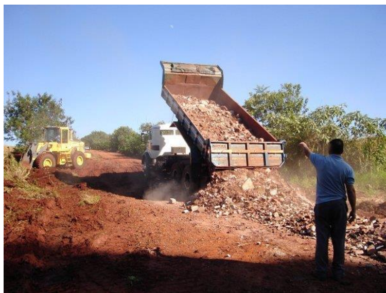
Figura 7 – Despejo do entulho na via a ser aproveitada.
