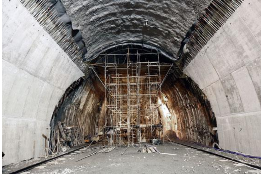
Figura 5.7 – Túnel executado em NATM.
