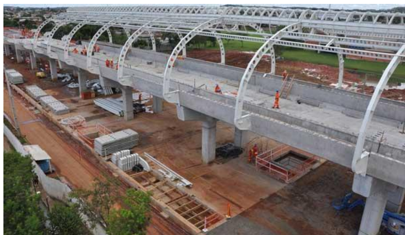
Figura 5.2 – Estação Liberdade em construção.
