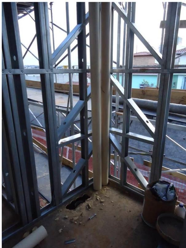
Figura 5.91 - Execução de passagem de tubulações pela laje seca
