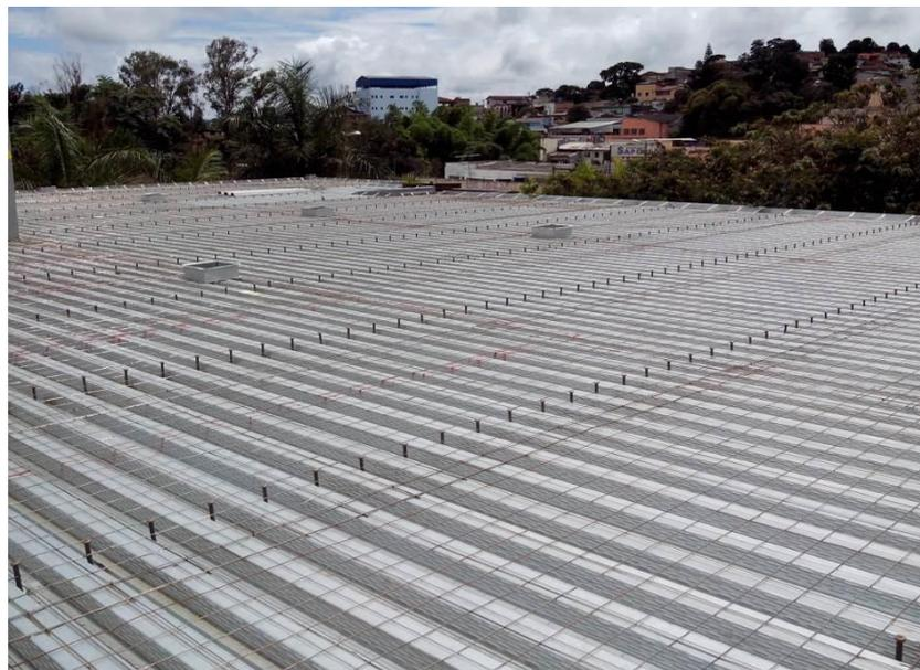
Figura 5.51 - Fôrma de aço de laje úmida tipo *Steel Deck*
