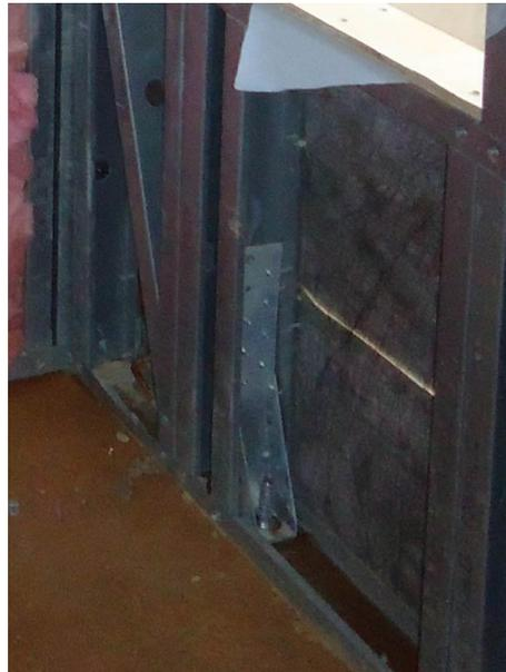
Figura 5.11 - Detalhe de ancoragem da estrutura na fundação
