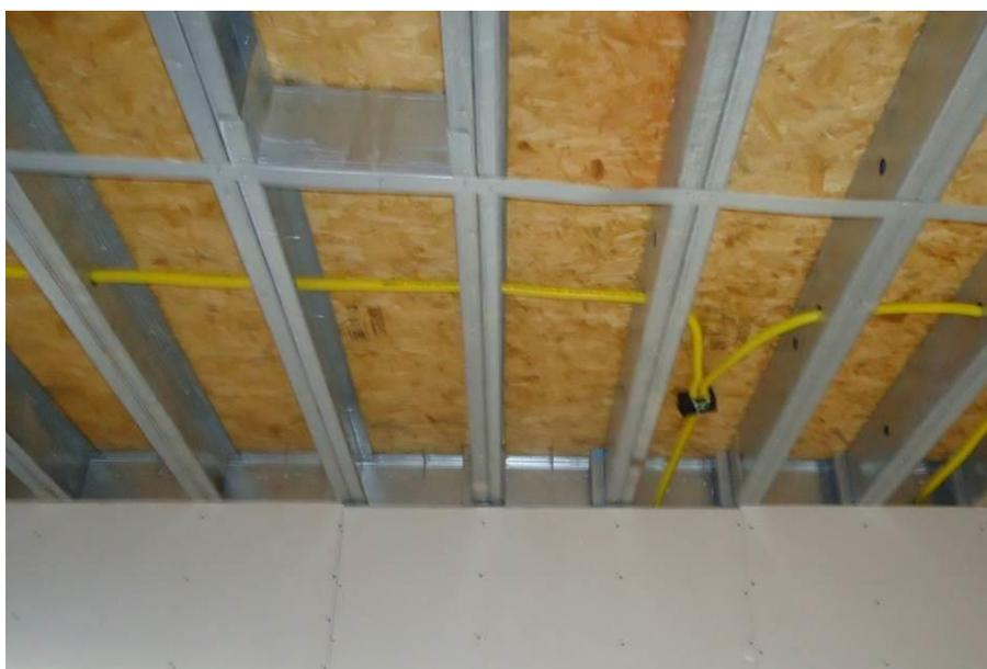
Figura 5.55 - Bloqueadore e fita metálica no travamento horizontal da laje
