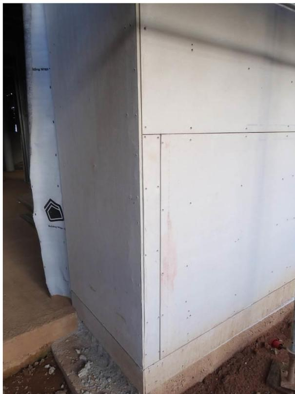
Figura 5.72 - Placa Cimentícia instalada na fachada com junta defasada
