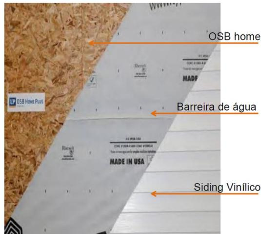
Figura 5.71 - OSB com acabamento final em “Siding” Vinílico
