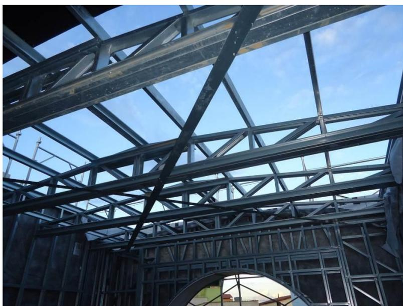
Figura 5.67 - Cobertura com elementos de contraventamento
