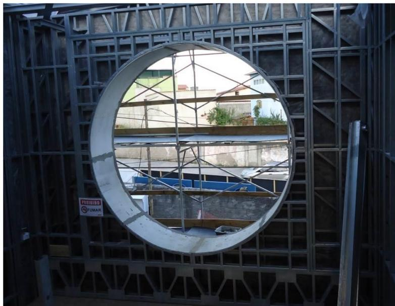
Figura 5.73 - Placa cimentícia instalada em abertura redonda
