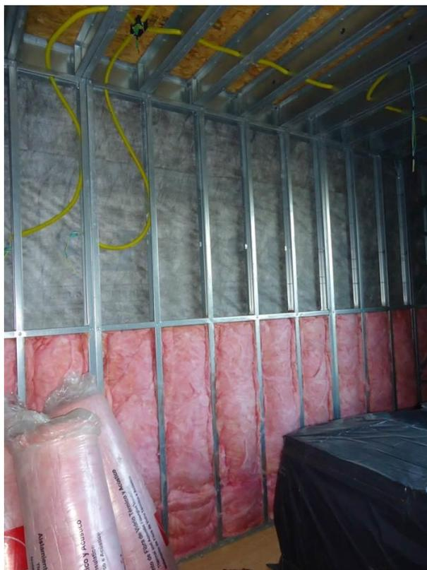
Figura 5.78 - Instalação parcial de lã de vidro em painel
