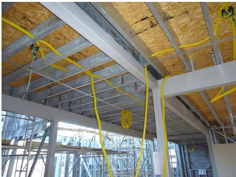
Figura 5.89 - Passagem de tubulação elétrica pelas vigas de piso
