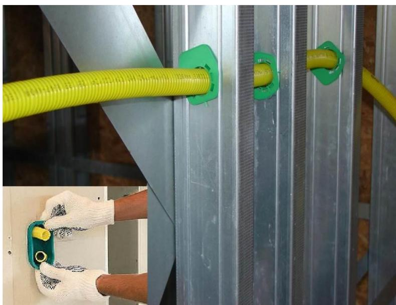
Figura 5.95 - Eletroduto com trava e caixas elétrica criada para LSF
