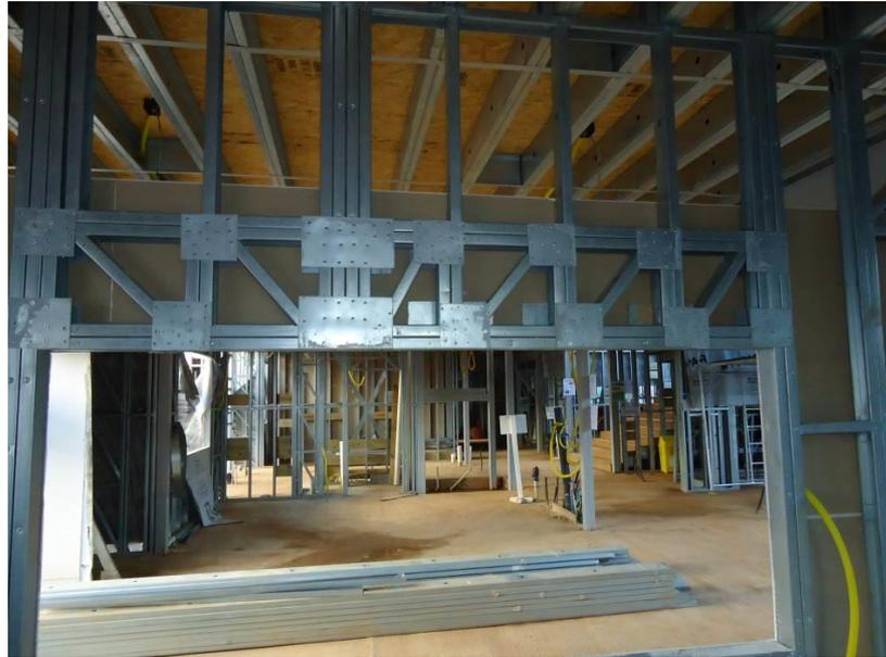
Figura 5.15 - Painel com abertura de janela
