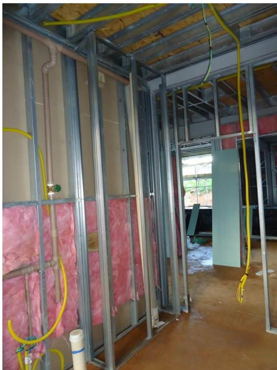
Figura 5.39 - Painel não-estrutural com montantes simples
