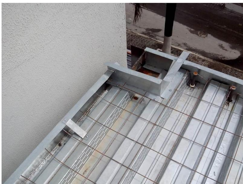
Figura 5.52 - Perfil galvanizado tipo cantoneira no perímetro da laje
