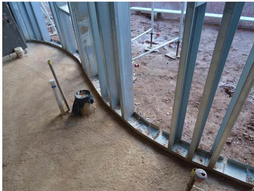
Figura 5.90 - Locação de pontos de instalações na Radier
