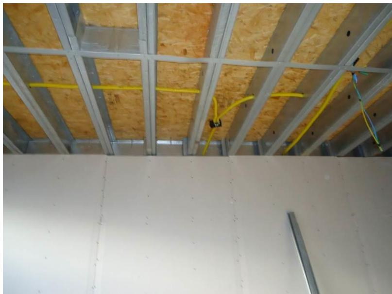
Figura 5.49 - Estrutura de piso em Light Steel Framing
