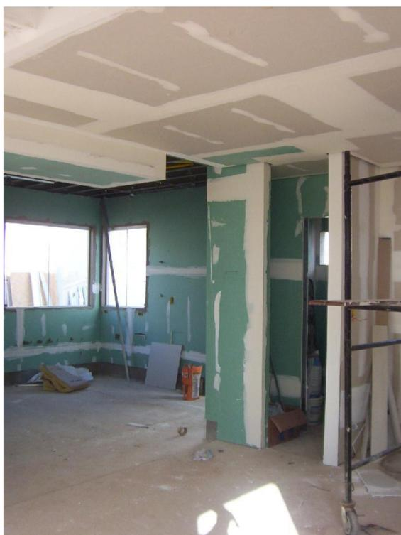
Figura 5.75 - Fechamento interno em DryWall e gesso acartonado
