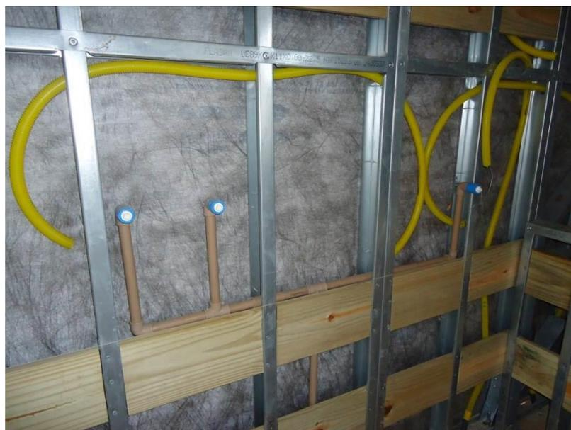
Figura 5.88 - Instalação predial executada antes do fechamento interno
