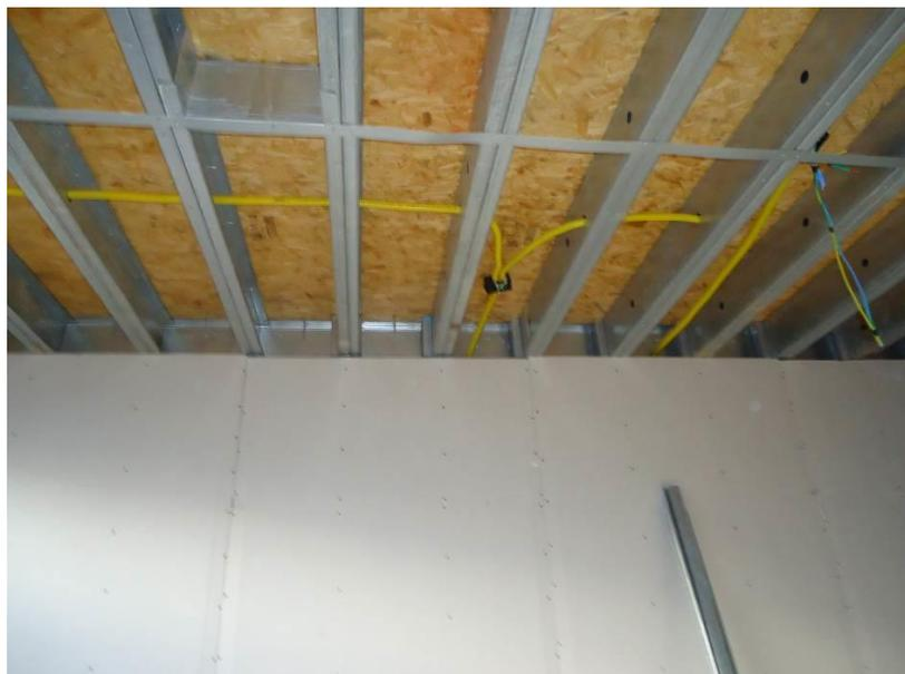
Figura 5.4 - Vista da estrutura do piso com vigas em perfis galvanizados
