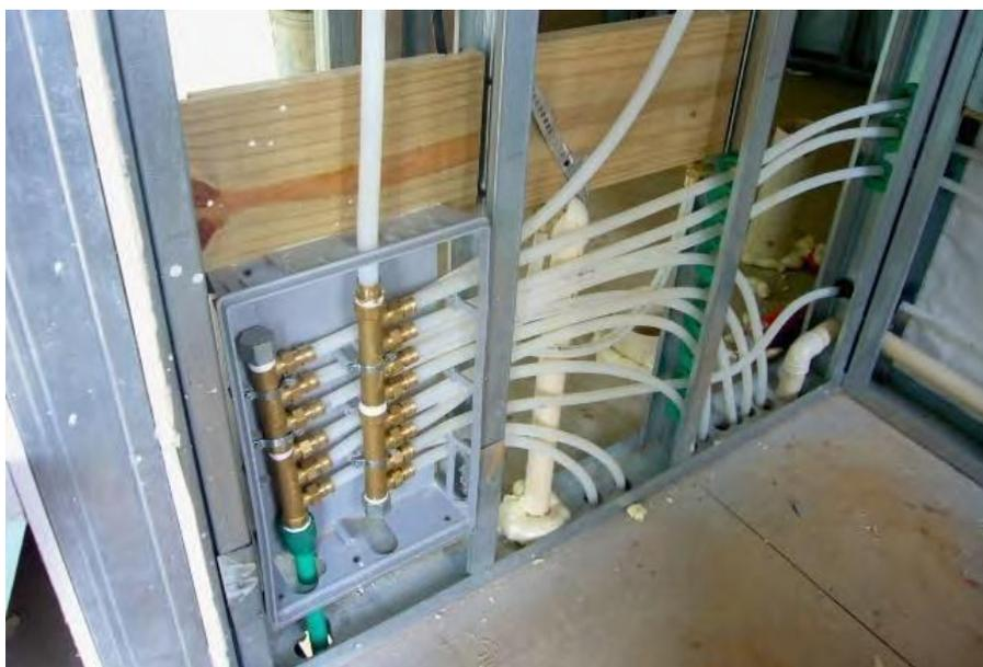
Figura 5.92 - Sistema PEX instalado em construção LSF
