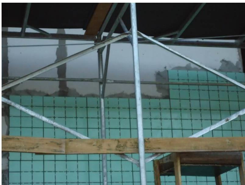
Figura 5.74 - Acabamento em pastilha cerâmica sobre placa cimentícia
