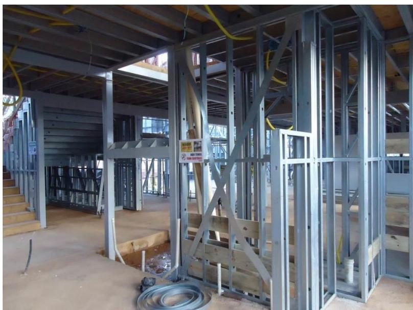
Figura 5.22 - Painel com contraventamento em “X”
