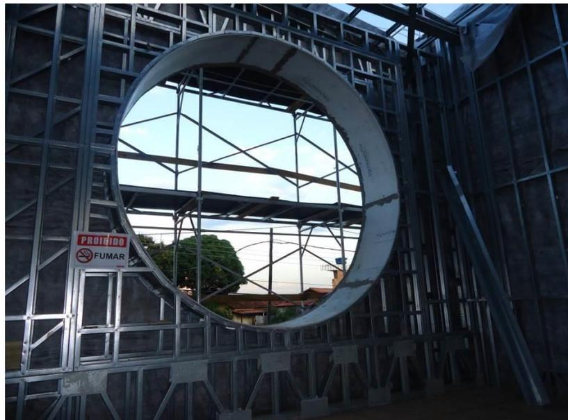
Figura 5.44 - Painel de fachada com abertura redonda
