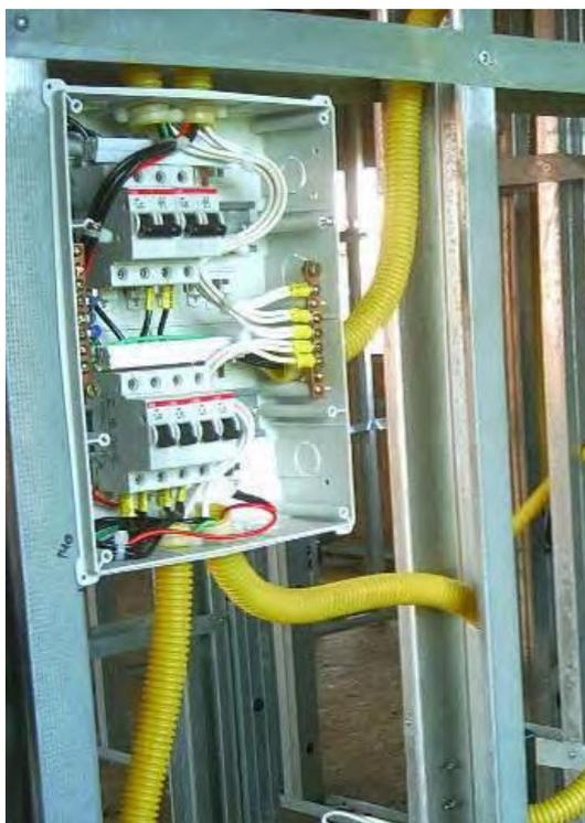
Figura 5.94 - Instalação elétrica instalada em construção LSF
