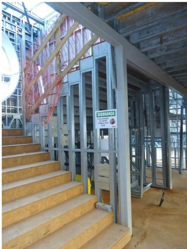
Figura 5.60 - Escada executada com o método de painéis escalonados
