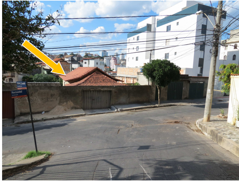
Figura 4.1: Vista frontal do edifício construído e da casa vistoriada, indicada pela seta amarela.
