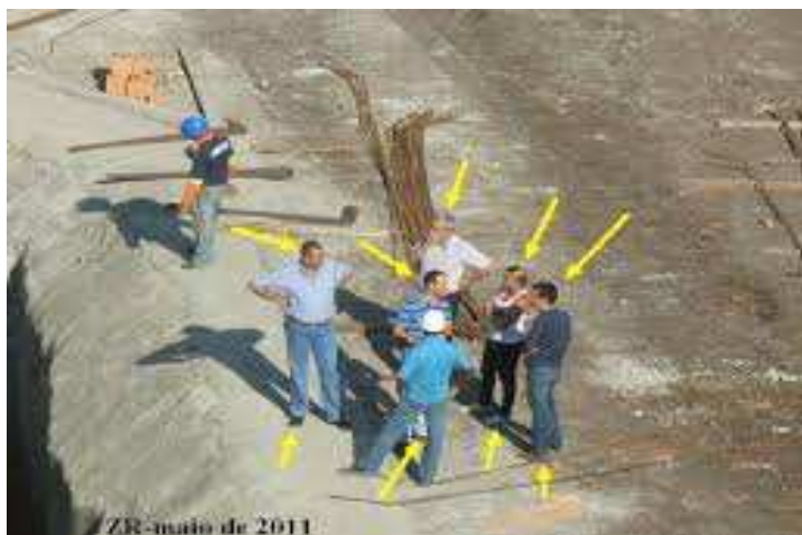
Figura 11: Risco de acidentes na obra
