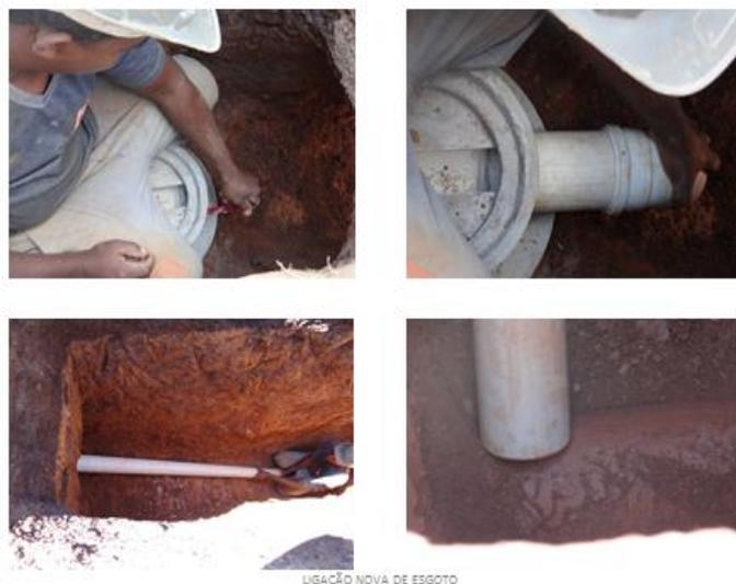
Figuras nº 60a, 60b, 60c, 60d: Montagem de ramal predial de esgoto. (Fonte: Acervo próprio)
