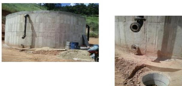
Figuras nº 37a, 37b: Reservatório de água em concreto armado.
