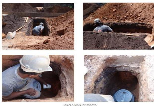
Figuras nº 59a, 59b, 59c, 59d: Escavação de vala para ligação predial de esgoto.
