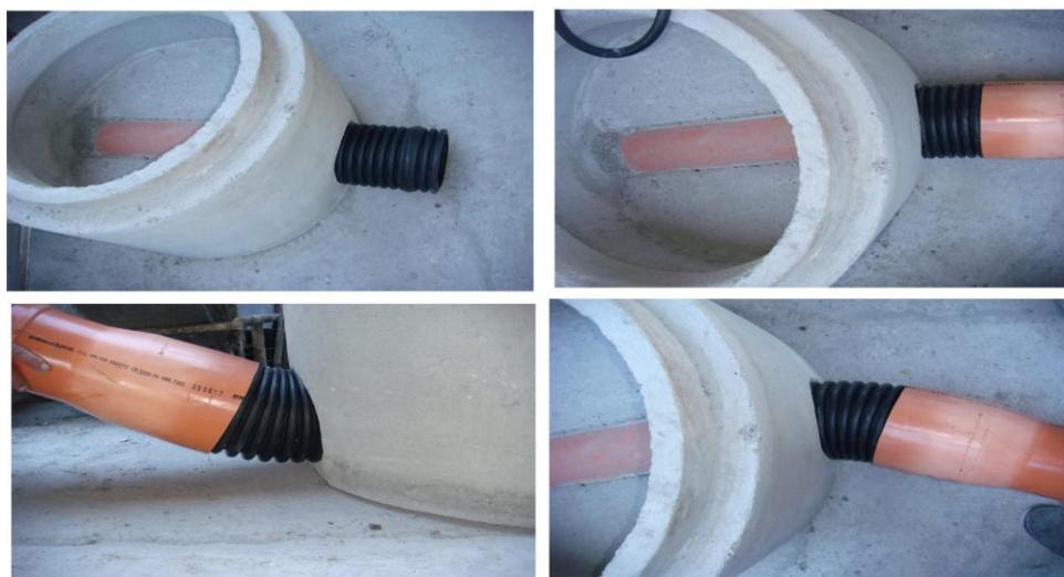
Figuras nº 100a, 100b, 100c, 100d: Tubulação flexível, na entrada do PV.
