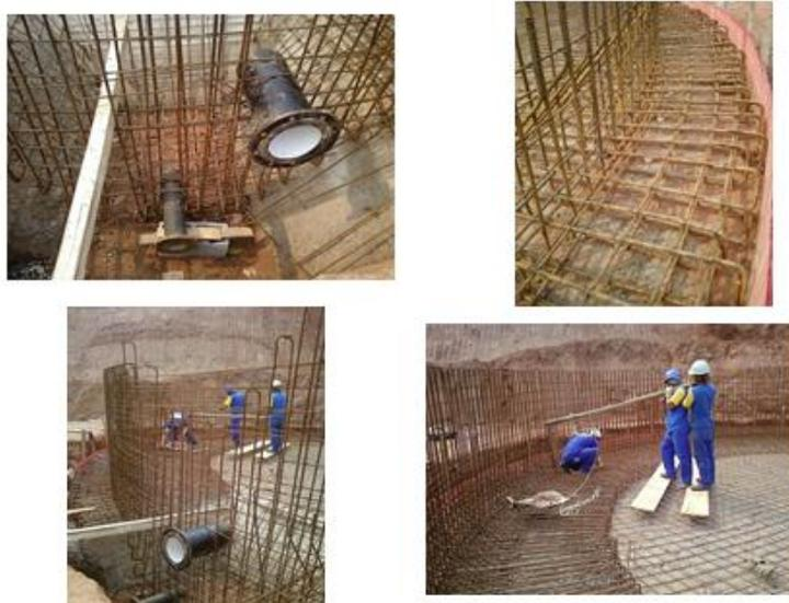
Figuras nº 36<sup>a</sup>, 36b, 36c, 36d: Construção de reservatório de água em concreto armado.( Fonte: Acervo próprio)
