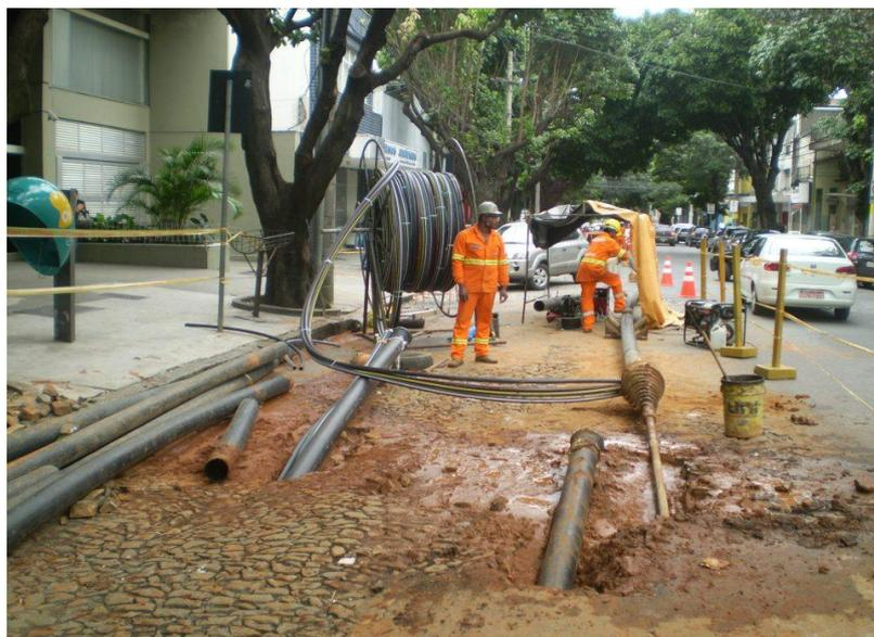
Figura nº 124: Alargamento e inserção do tubo. ( Fonte: Tecgas)
