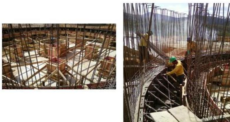
Figuras nº 71a, 71b: Detalhamento de ferragens. ( Fonte: Acervo próprio)
