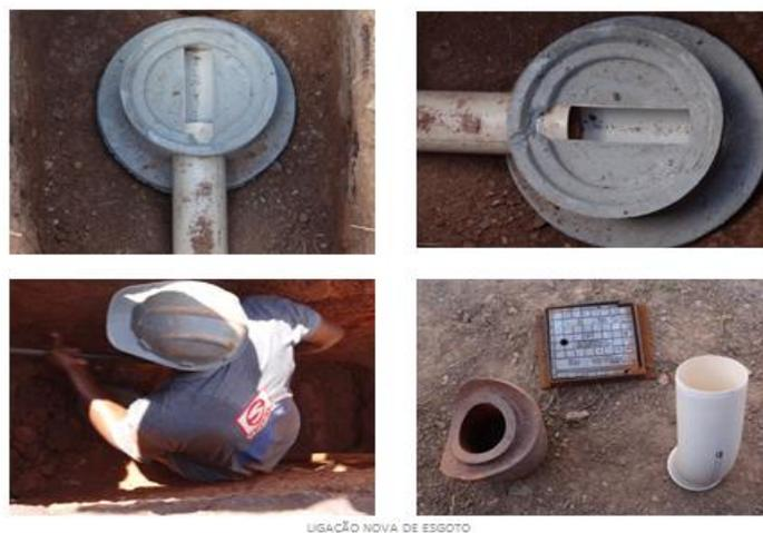
Figuras nº 58a, 58b, 58c, 58d: Peças e conexões para ligação de esgoto.
