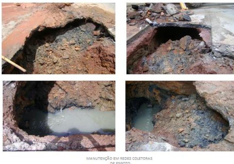
Figuras nº 45a, 45b, 45c, 45d: Rede coletora de esgoto rompida.
