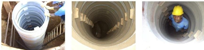
Figuras nº 95a, 95b, 95c, 95d, 95e, 95f: Montagem de PV (Fonte: Artefácil)
