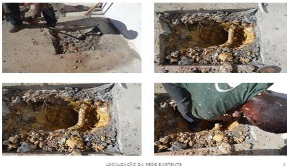
Figuras nº28a, 28b, 28c, 28d: Sondagem e localização da rede existente.
