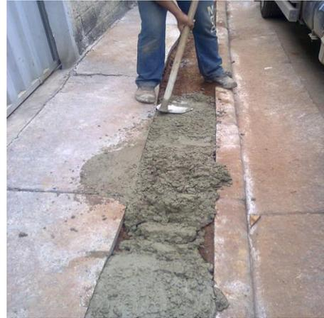
Figuras nº 38a, 38b: Construção de rede de água potável, em passeio de concreto. ( Fonte: Acervo próprio)
