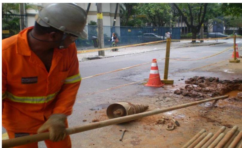
Figura nº 122: Pré- alargamento. ( Fonte: Tecgas)
