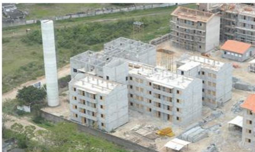
Figura nº 105: Execução de reservatório em anéis de concreto. (Fonte: Artefácil)
