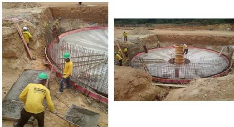
Figuras nº 72a, 72b: Processo de concretagem. ( Fonte: Acervo próprio)
