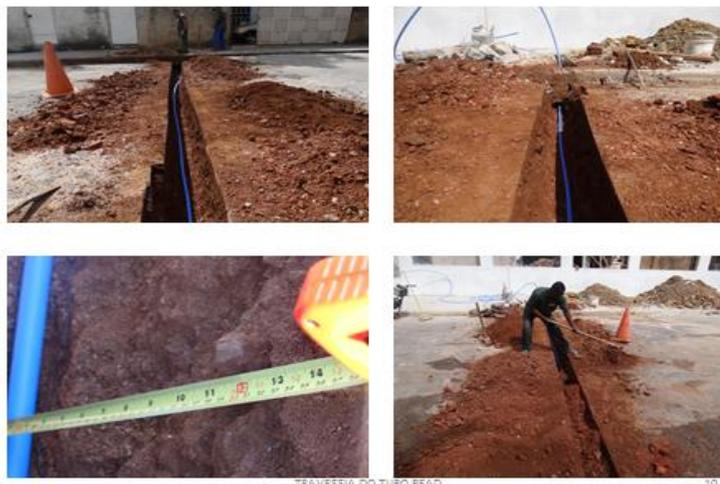
Figuras nº 34a, 34b, 34c, 34d: Passagem do ramal pela travessia. ( Fonte: Acervo próprio)
