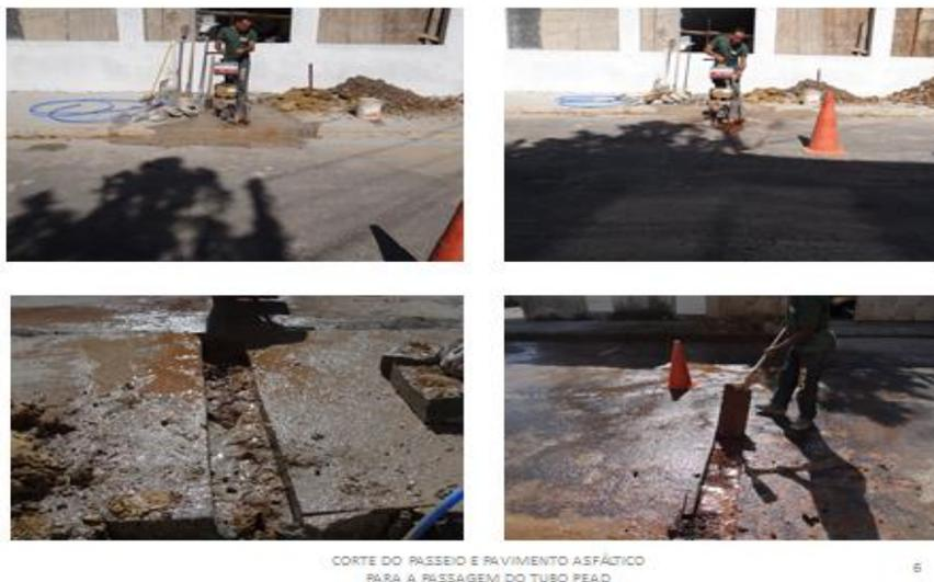
Figuras nº 30a, 30b, 30c, 30d: Corte no pavimento asfáltico.
