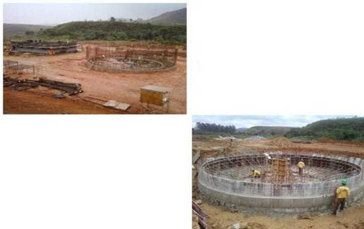
Figuras nº 68a, 68b: Construção de reator. ( Fonte: Acervo próprio)
