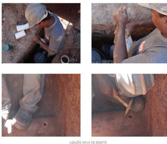
Figuras nº 61a, 61b, 61c, 61d: Processo construtivo para ligação predial de esgoto. ( Fonte: Acervo próprio)
