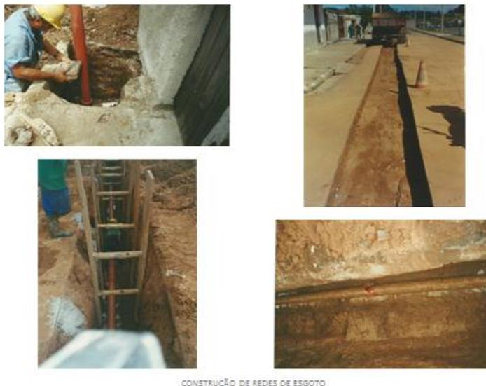
Figuras nº 56a, 56b, 56c, 56d: Construção de rede coletora de esgoto.
