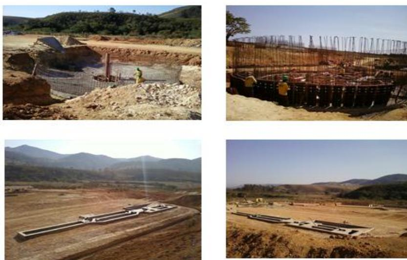
Figuras nº 69a, 69b, 69c, 69d: Construção de reator e leito de secagem. ( Fonte: Acervo próprio)
