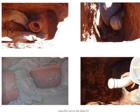
Figuras nº 63a, 63b, 63c, 63d: Interligação das peças, na rede existente.
