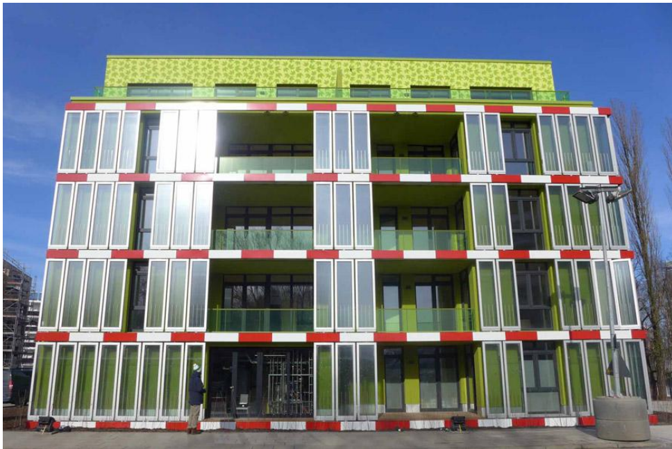
Figura 4: Edificação alemã que utiliza Microalgas para aquecimento interno.
