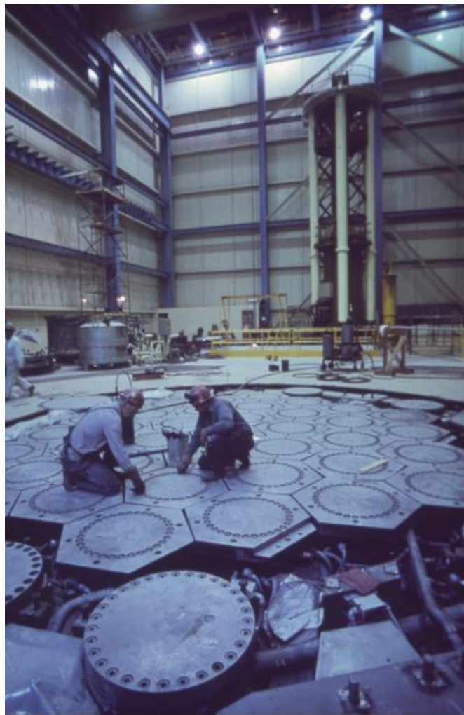
Figura 2.13 – Recarregamento do VHTR de bloco prismático em Fort Saint Vrain.
