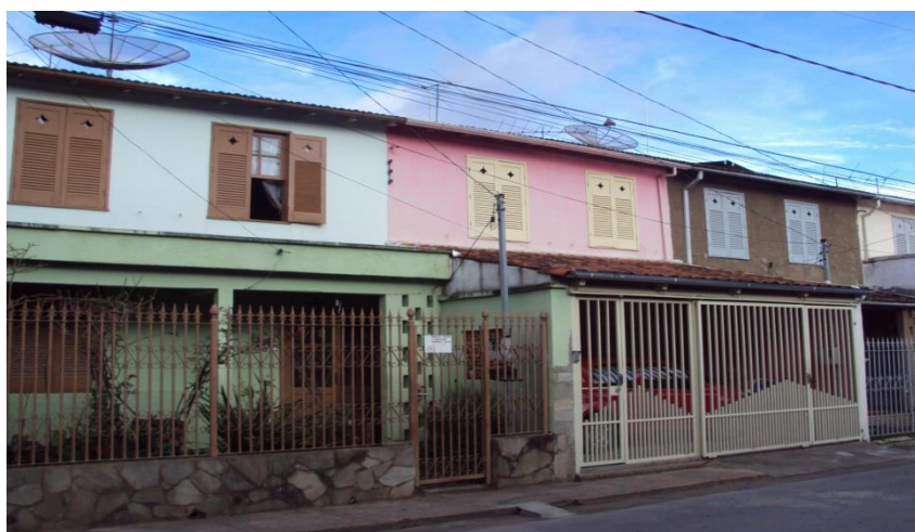
Foto 17 - Casas construídas nos anos 1950 que formam o conjunto IAPI.
