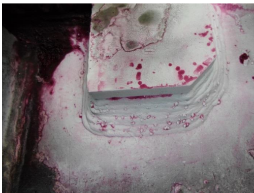
Figura 4.3: Descontinuidade R1 – d1.
