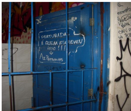
Foto 7 – Porta banheiro externo
