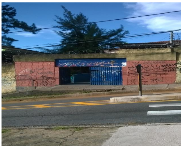
Foto 2 – Fachada e portão de entrada da escola
