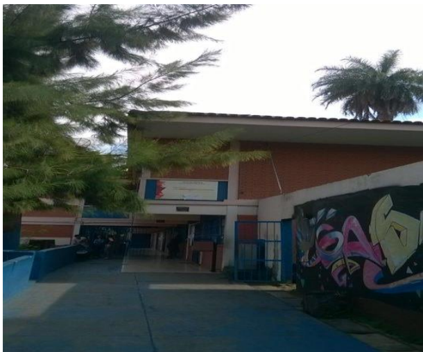
Foto 4 – Rampa de entrada: parte interna
