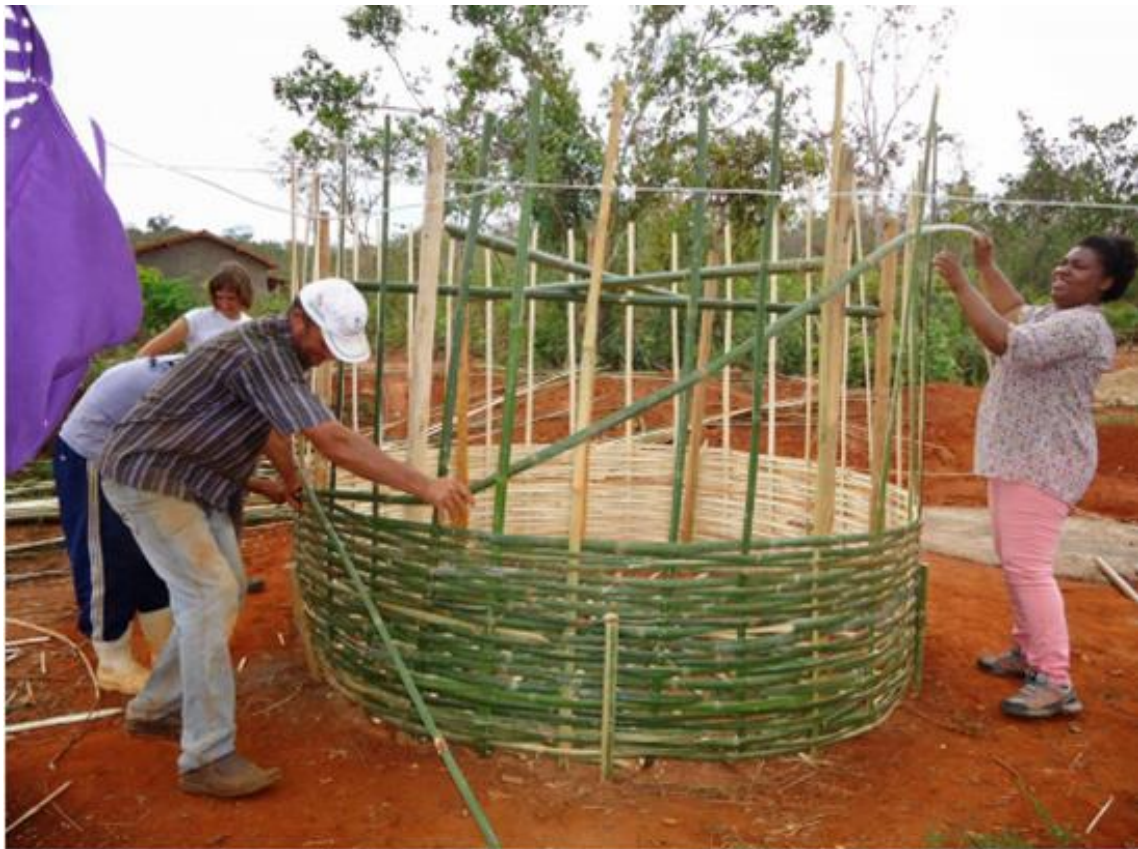
Figura 8: Confeção da estrutura lateral em forma de balaio
