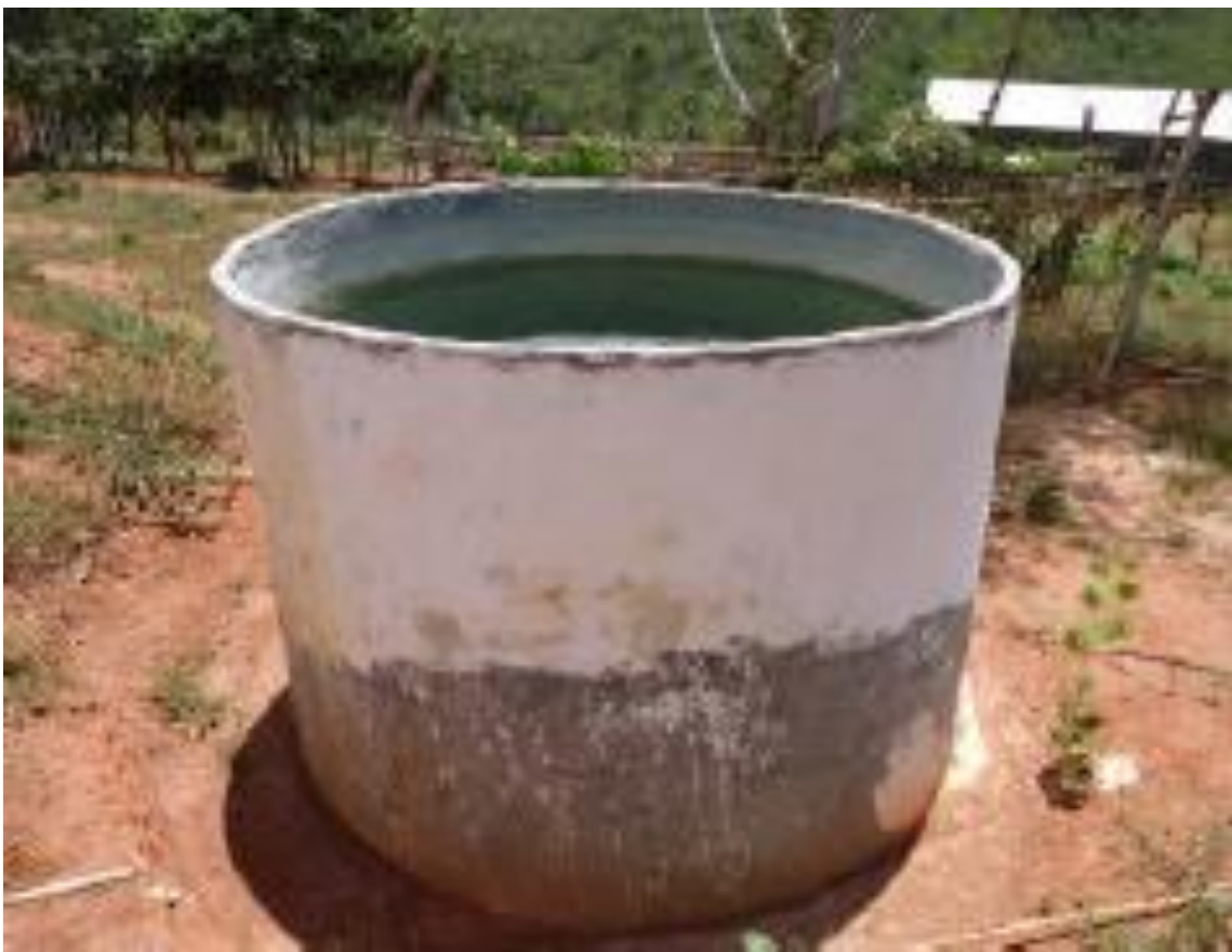
Figura 13: Reservatório em funcionamento
