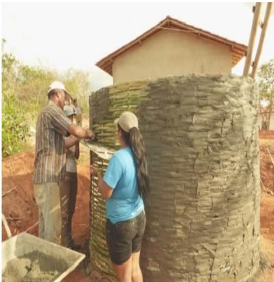
Figura 11: Revestimento do reservatório
