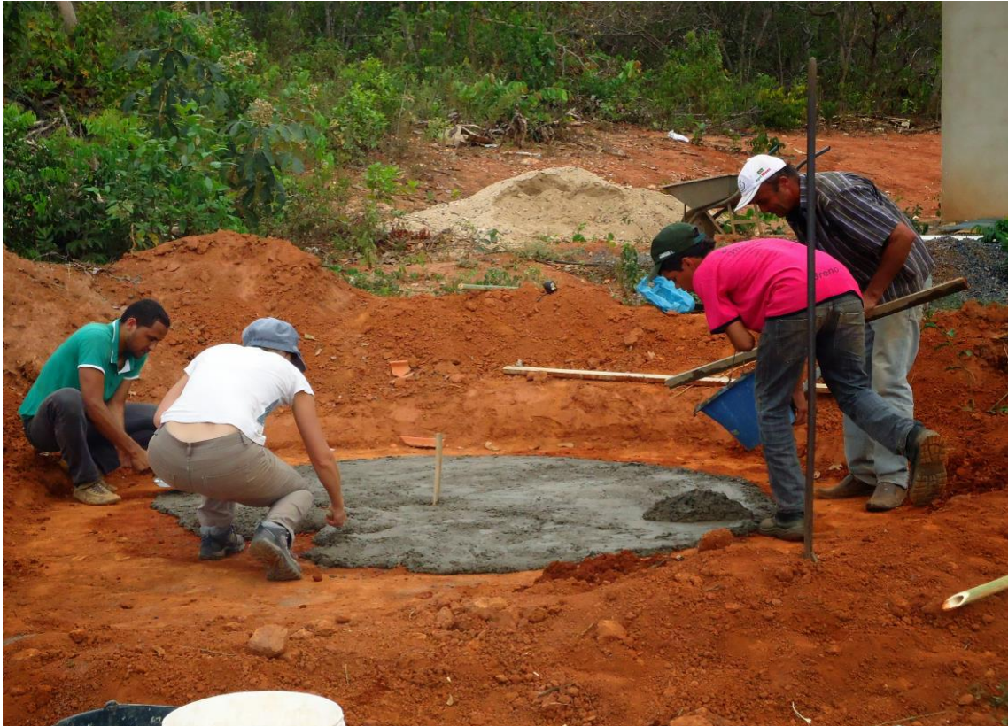
Figura 7: Assentamento do contra piso
