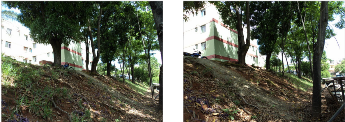
Figuras 7 e 8: erosão em talude iniciada por drenagem irregular por água de enxurrada. Fonte: Autor, 2015.
