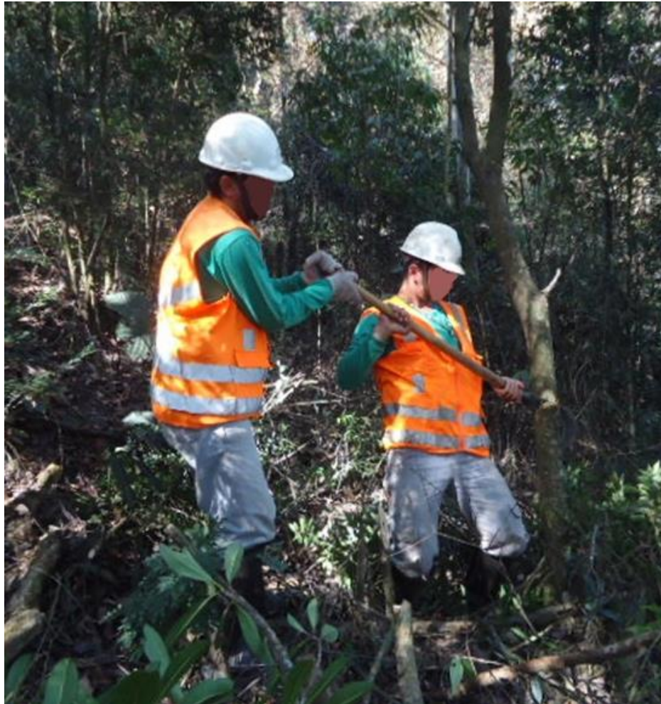
Figura 7 - Corte de arvores para desobstrução do sinal GPS
