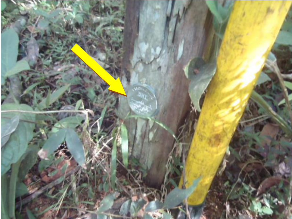
Figura 8 – Placa identificadora implantada na cerca que delimita a área da Linha Férrea com o confrontante.
