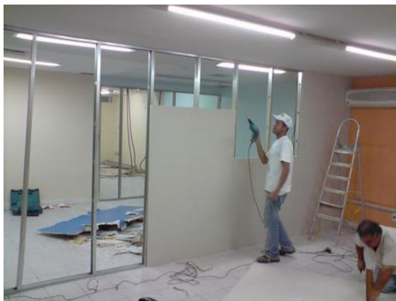
Figura 13. Instalação de chapas drywall.
