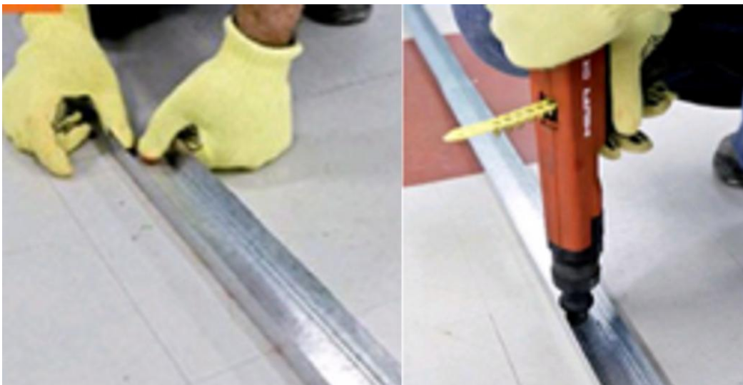
Figura 11: Instalação de guias
