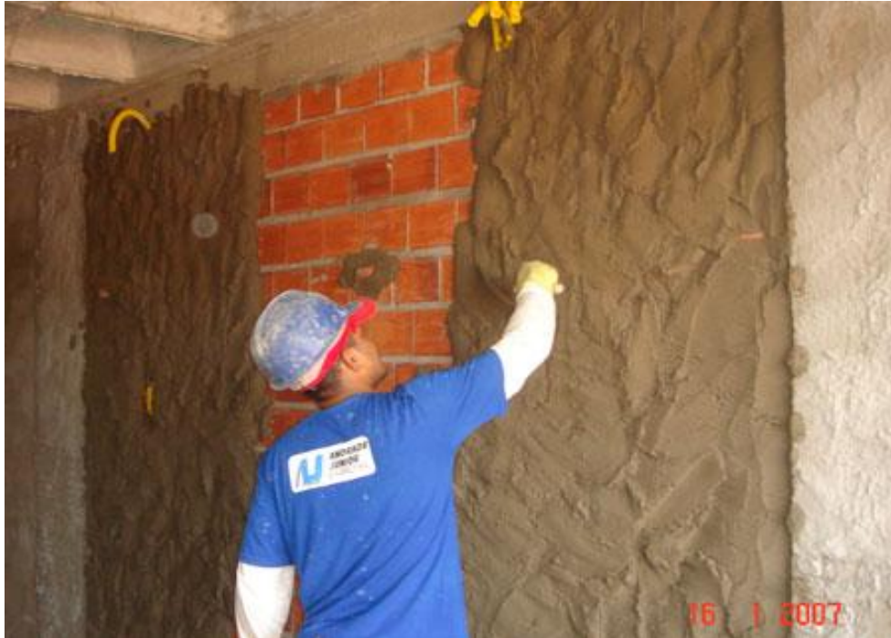
Figura 25: Preparo de superfície para posterior revestimento cerâmico.
