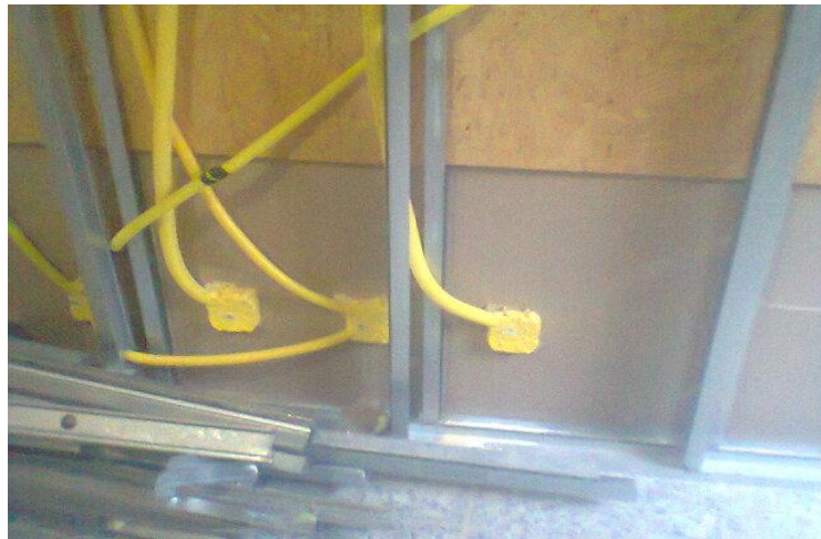
Figura 23: Fixação das placas e passagem de tubulações
