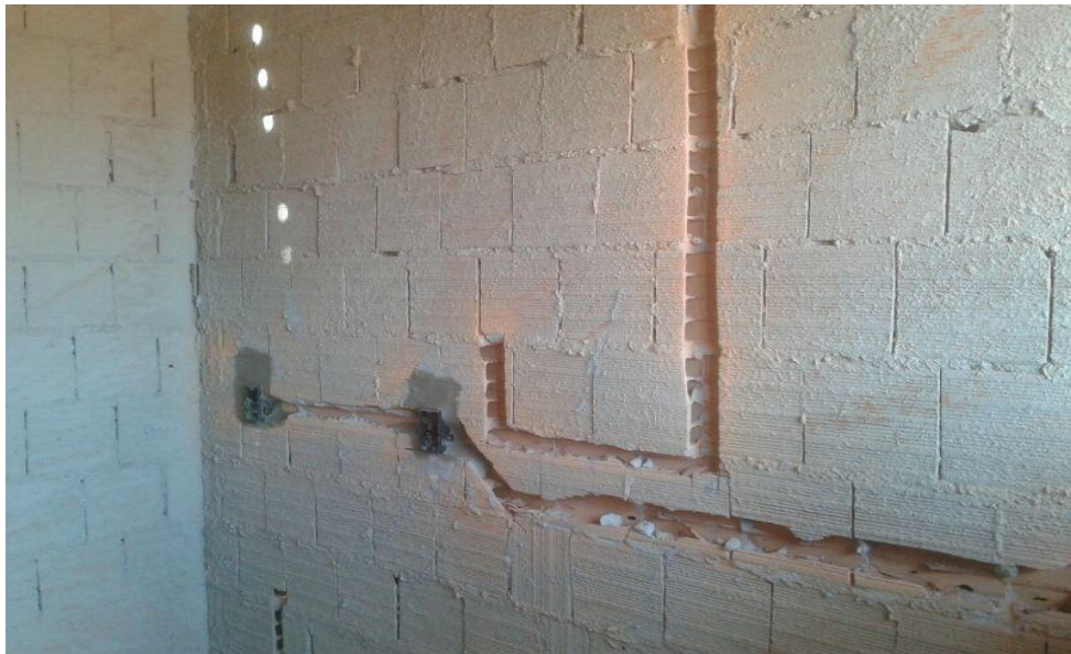
Figura 22: Corte em alvenaria para instalação elétrica.
