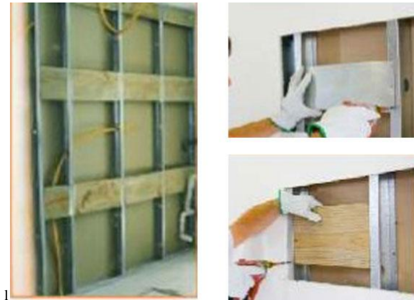
Figura 18: Instalação de reforço em drywall
