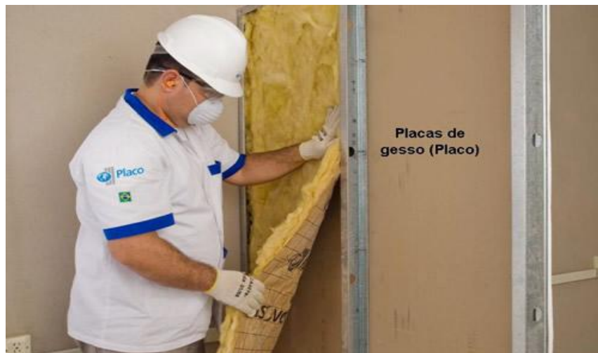
Figura.17: Instalação de isolamento acústico.
