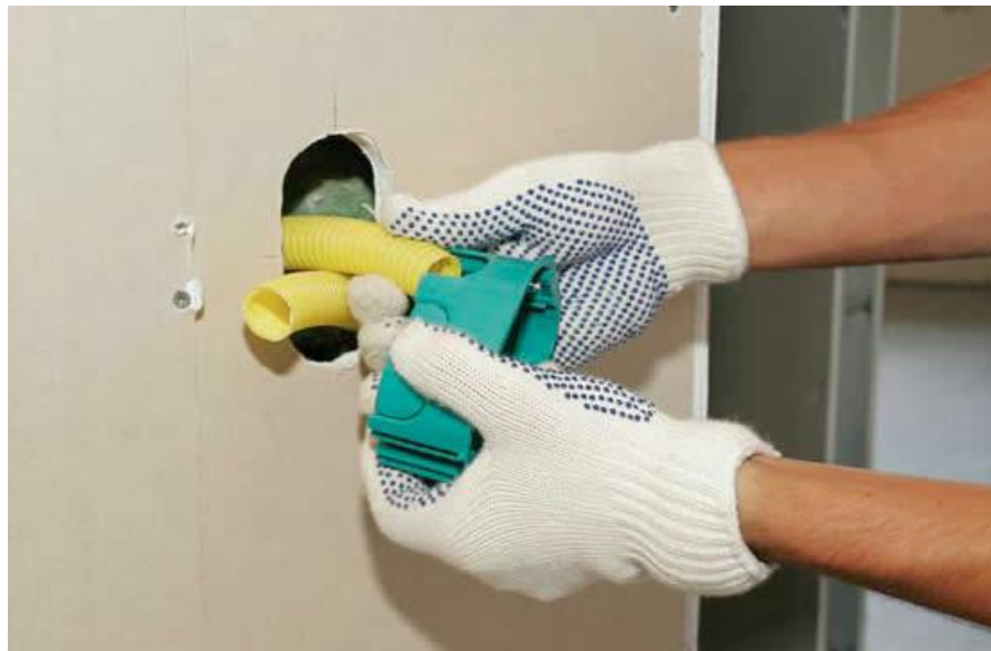
Figura 14: Instalação de caixas elétricas.
