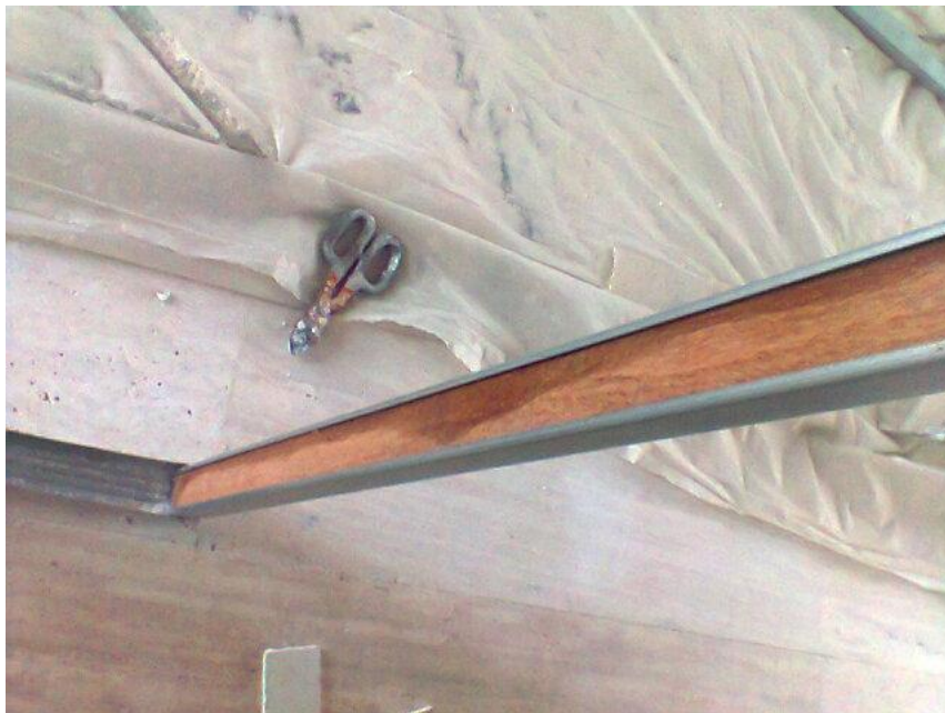
figura 20: Fixação de perfis para posterior fixação das placas
