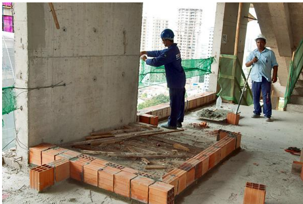
Figura 21: Marcação de alvenaria
