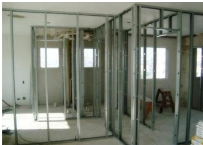
Figura 12 Instalação de montantes
