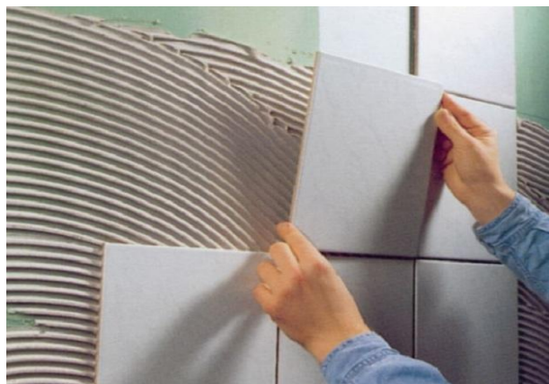
Figura 24: Fixação de elemento cerâmico sobre placa RU
