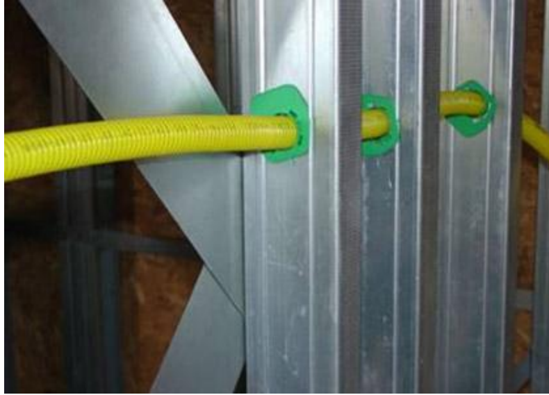
Figura 15: Proteção de tubulação em drywall
