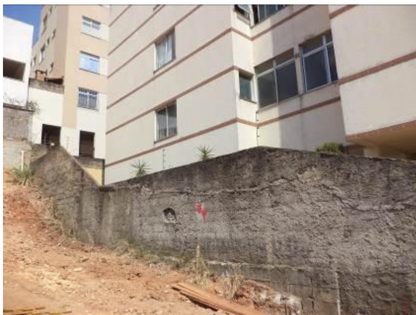
Figura 10: Vista interna do terreno da obra, na divisa com o imóvel 1.
