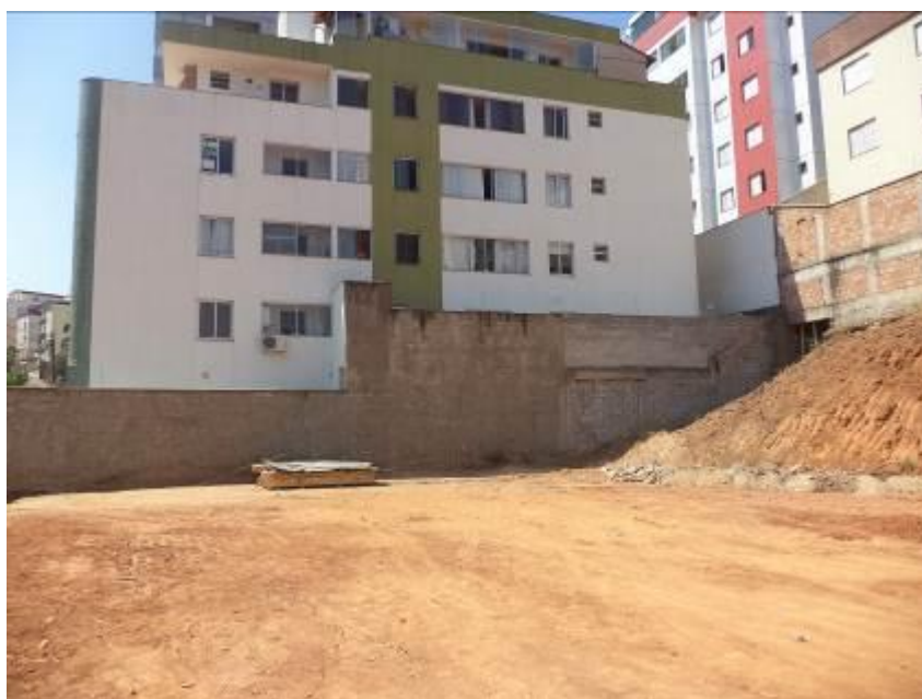
Figura 14: Vista interna do terreno da obra próximo à divisa com o imóvel 2.
