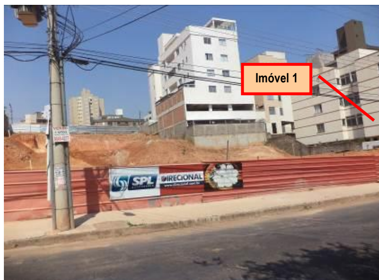
Figura 5: Vista frontal do terreno da obra, imóvel 1 à direita.
