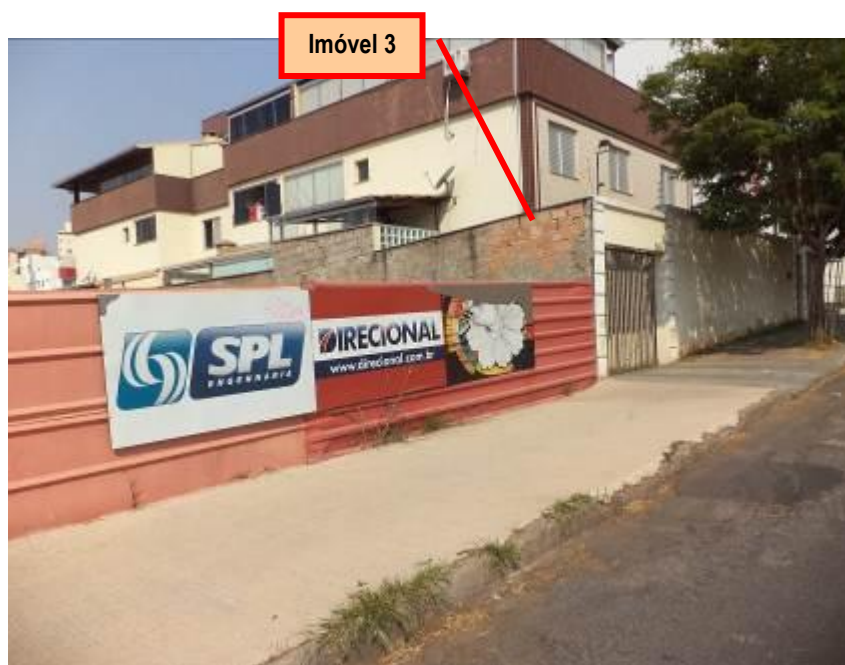
Figura 7: Vista frontal do terreno da obra, imóveis 3 e 4 ao fundo.
