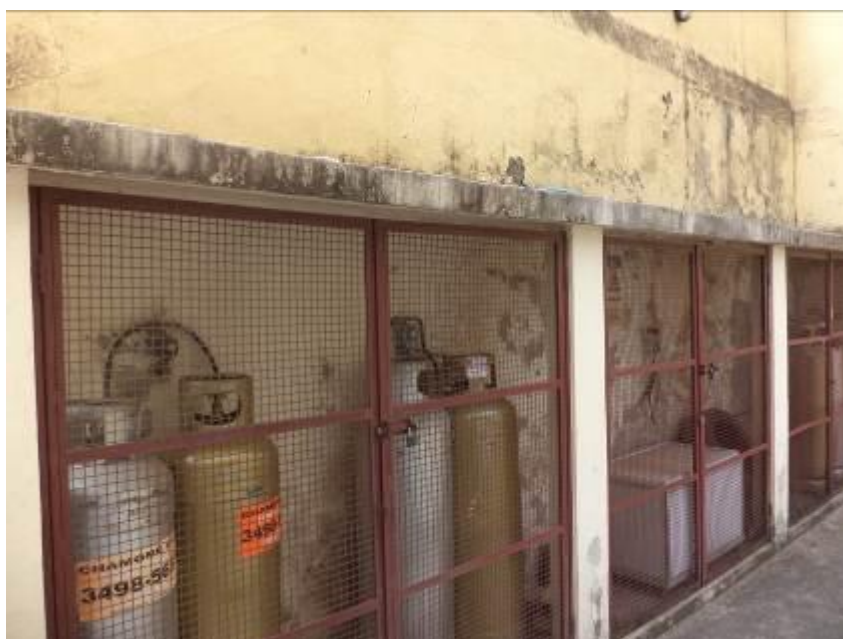
Figura 25: Vista do depósito de gás construído junto ao muro de divisa.
