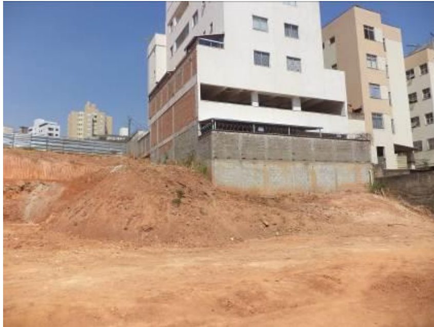
Figura 11: Vista interna do terreno da obra, imóvel 4 ao fundo.
