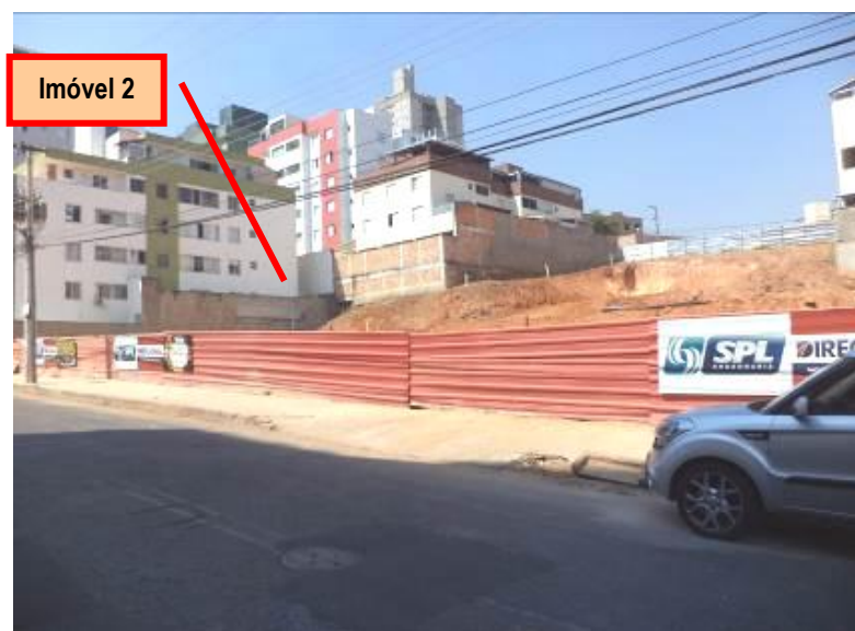
Figura 6: Vista frontal do terreno da obra, imóvel 2 à esquerda.
