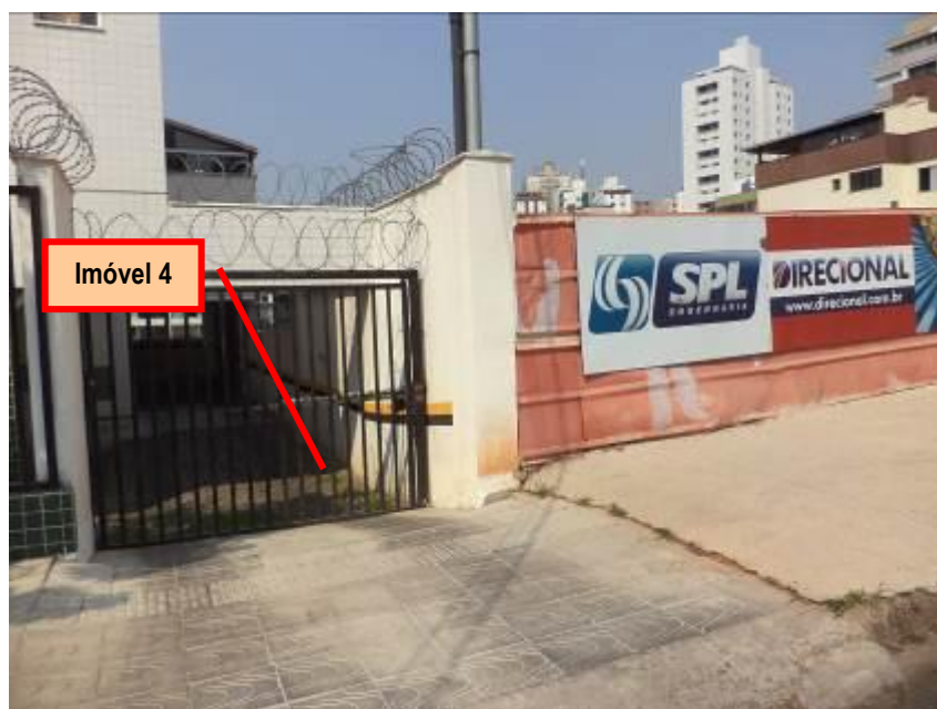
Figura 9: Vista do fundo do terreno da obra, imóvel 4 à esquerda.
