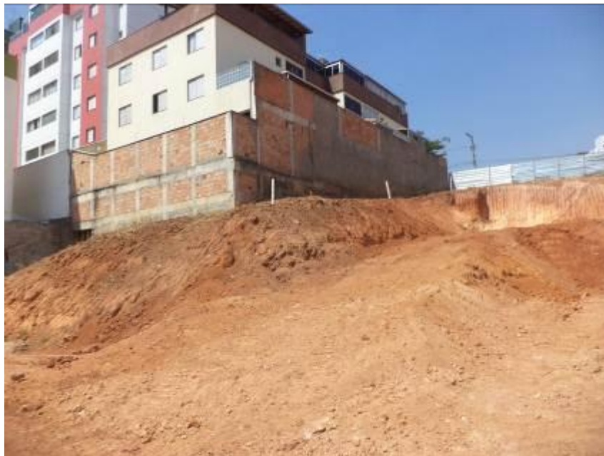
Figura 12: Vista interna do terreno da obra, imóvel 3 ao fundo.
