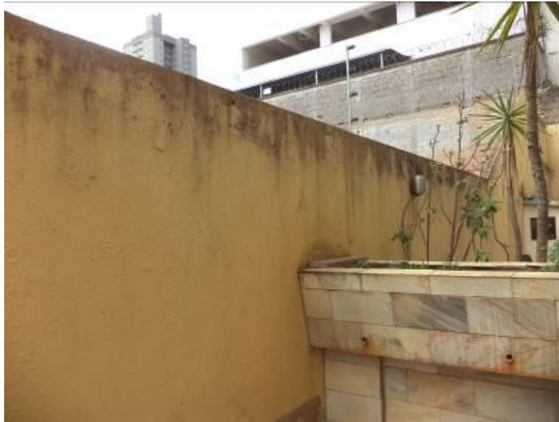
Figura 20: Vista do muro de divisa do imóvel 1 com o terreno da obra na parte intermediária.
