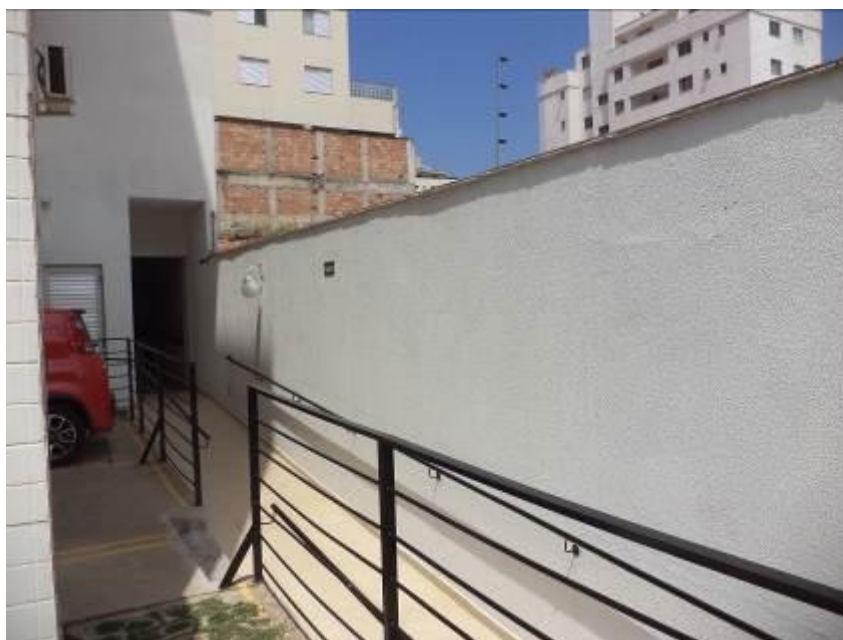
Figura 31: Vista do muro de divisa do imóvel 2 com o terreno da obra na parte frontal.
