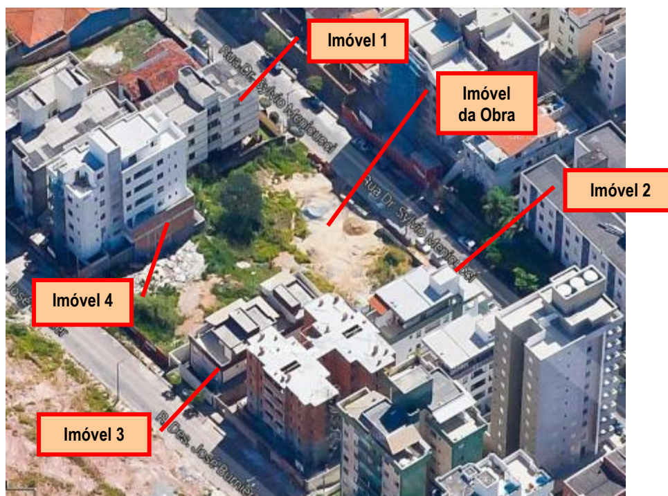
Figura 4: Vista aérea do imóvel da obra e dos imóveis vizinhos vistoriados
