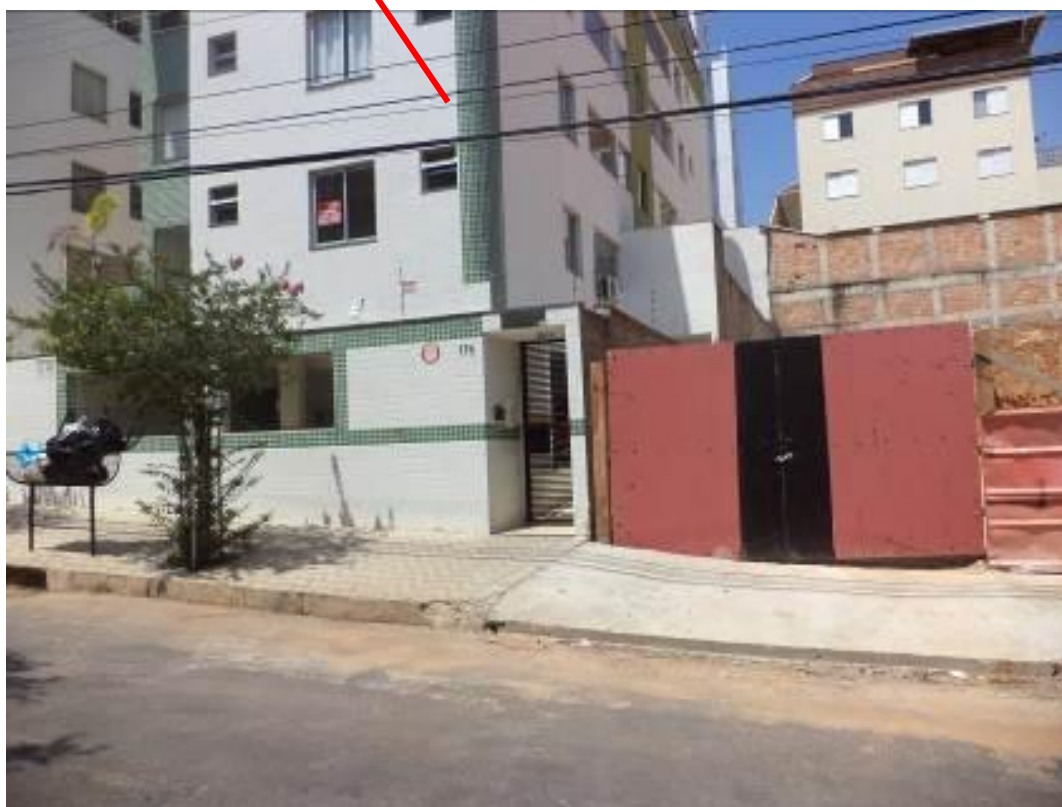
Figura 28: Vista frontal do imóvel 2, terreno da obra à direita
