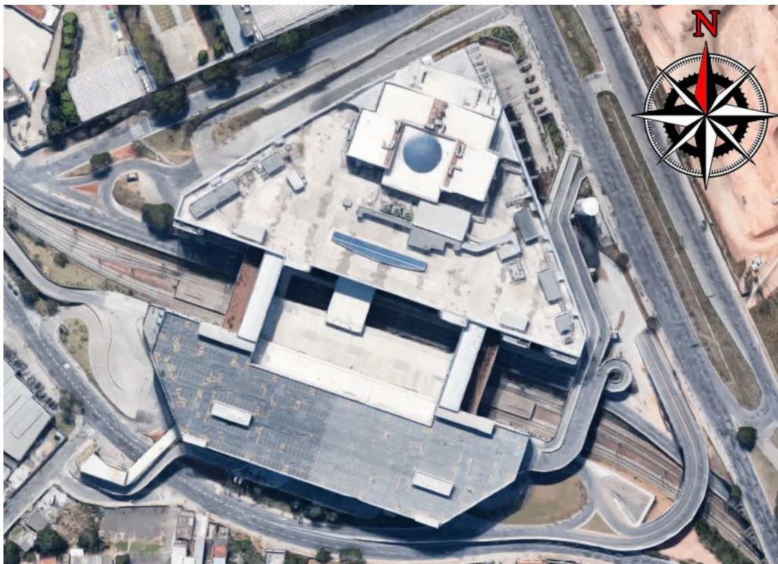
Figura 17 – Estação MOVE Vilarinho – vista superior
