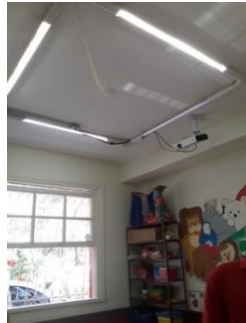
Figura 6 - Sala de Aula Detalhe para a disposição das luminárias Fonte: Arquivo Pessoal
